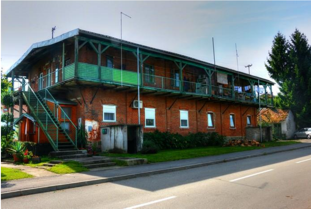
Slikovni prilog 15. Zelena Kuća. Fotografija objavljena na stranicama grada Orahovice, [s.a.]
