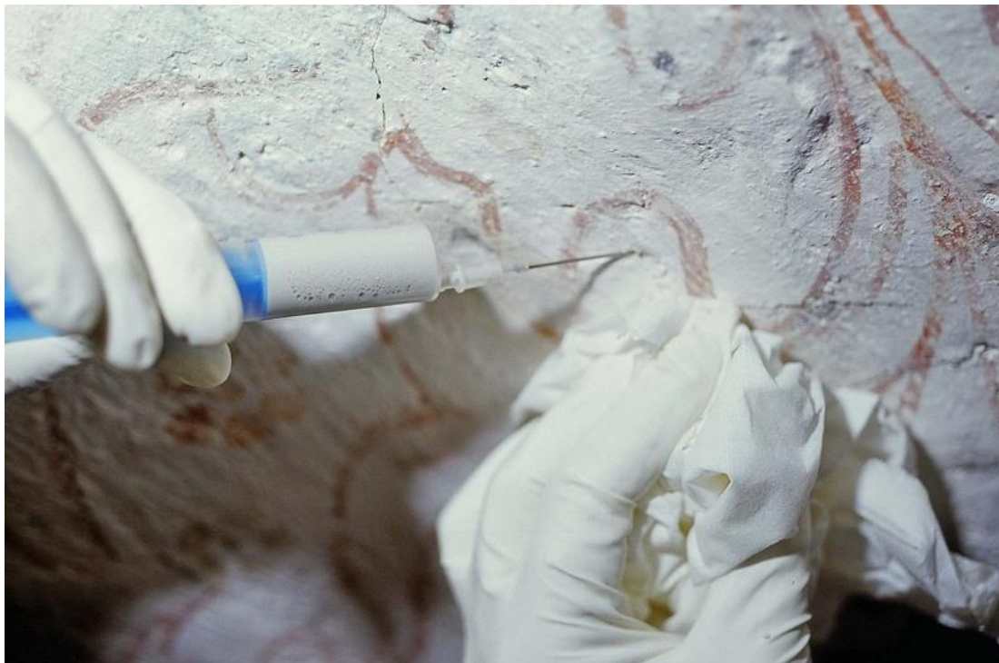
Prilog 21. Fotografija, injektiranje zidnih slika u crkvi svetog Ivana u Ivaniču Miljanskom. Izvor: Hrvatski restauratorski zavod , https://www.hrz.hr/images/stories/ivanic_miljanski/gallery.html , pregledano: 28. 9. 2023.
