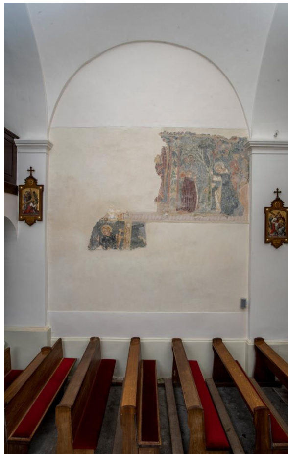
Prilog 10. Fotografija, stanje oslika na sjevernom zidu broda crkve svetog Brcka podno Kalnika nakon konzervatorsko-restauratorskih radova. Autor fotografije: Jovan Kliska
