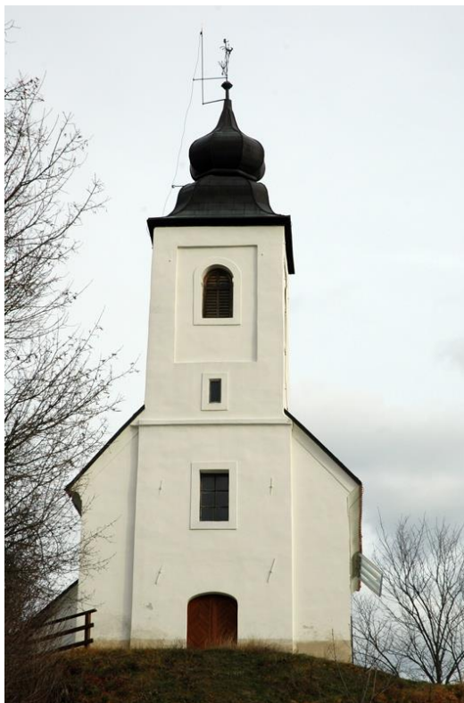
Prilog 18. Fotografija, crkva svetog Ivana u Ivaniću Miljanskom – pogled prema pročelju.
