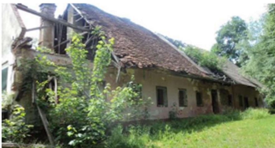
Slika 32. Prikaz stambeno-gospodarske zgrade iz arhiva Konzervatorskog odjela Zagreb
