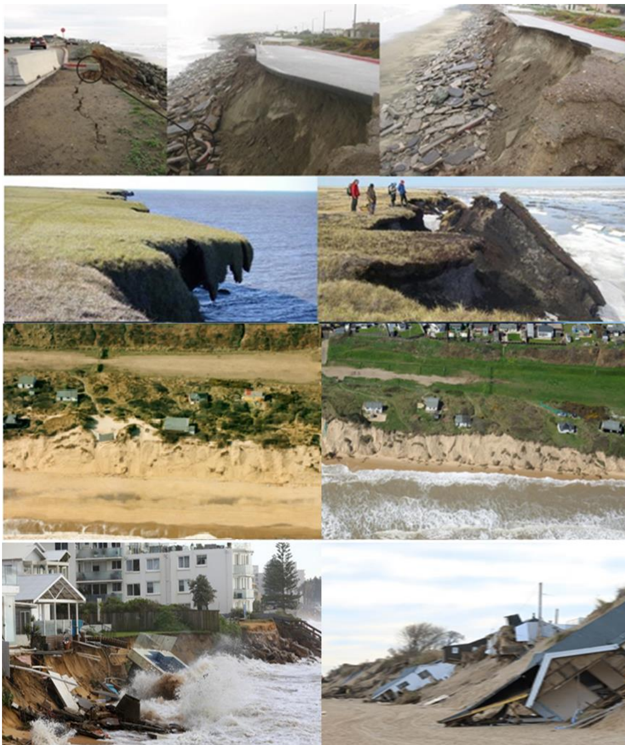
Slika 8. Primjeri negativnih posljedica obalne erozije
