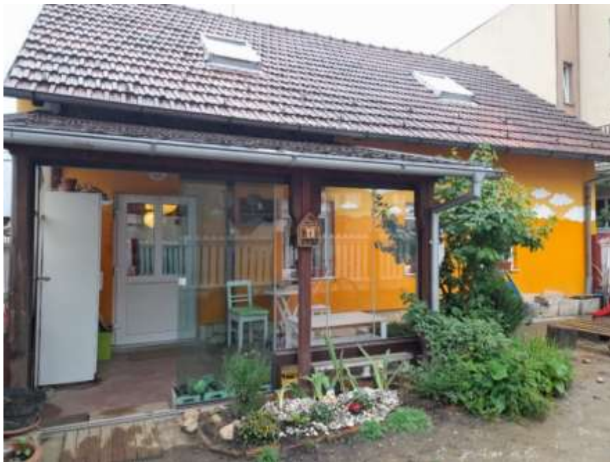
Slika 29. Pogled na kuću dječjeg vrtića
