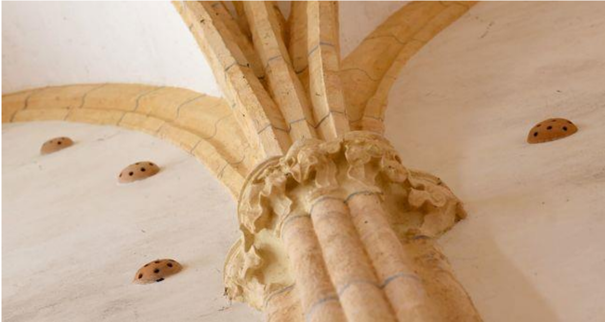
Slika 12. Štimance – akustične posude u zidovima stare crkve kartuzijskog samostana u Pleterju, Slovenija
