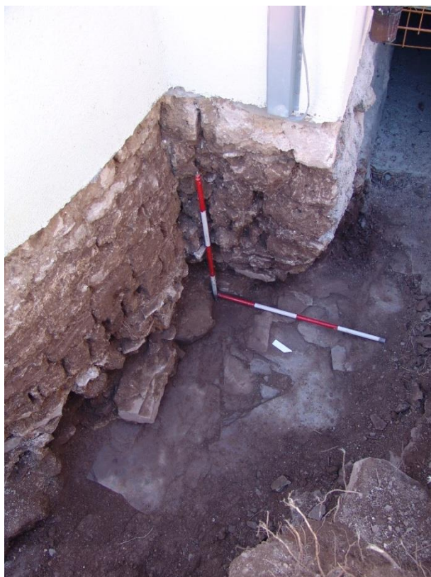
Prilog 20. Spoj sjevernog ugla broda i apside s pogledom na izvršeni iskop do kamena živca, 2015. godina, foto: dr. sc. Marko Sinobad
