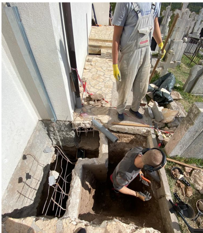
Prilog 26. Izvedba radova na Sondi 1, foto: Dolores Perković
