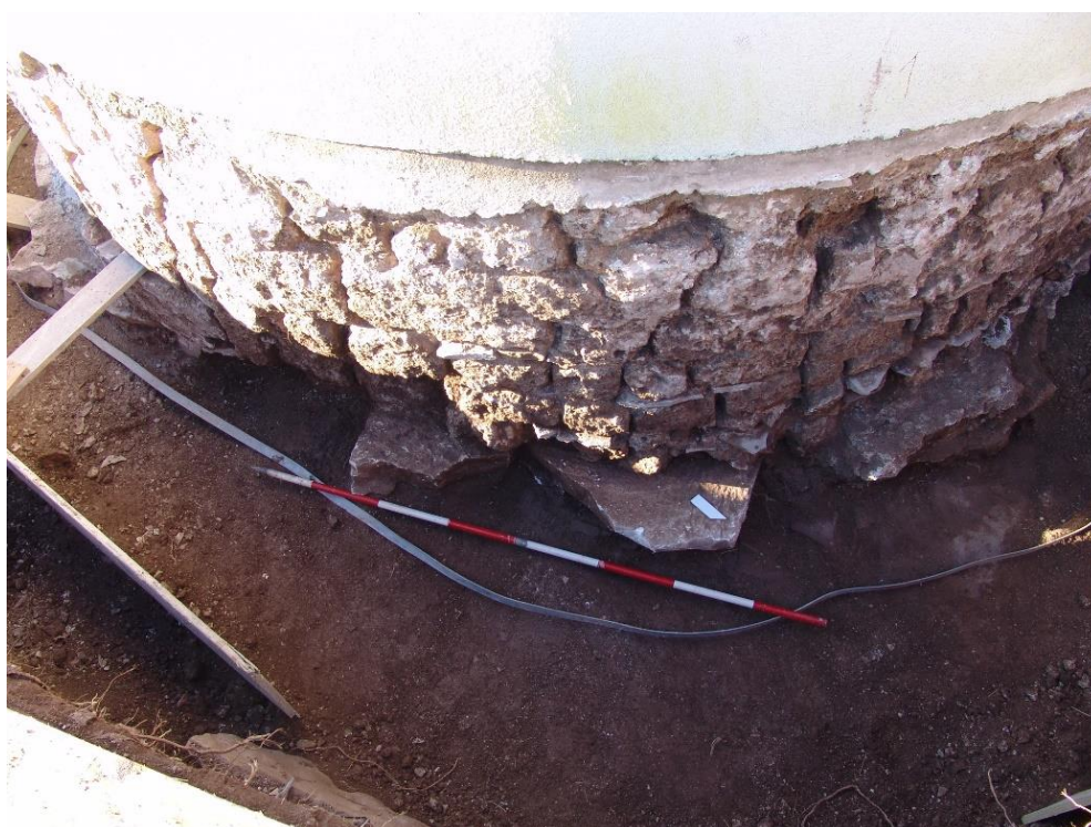
Prilog 21. Temelji apside, vidljive kamene ploče, 2015. godina, foto: dr. sc. Marko Sinobad
