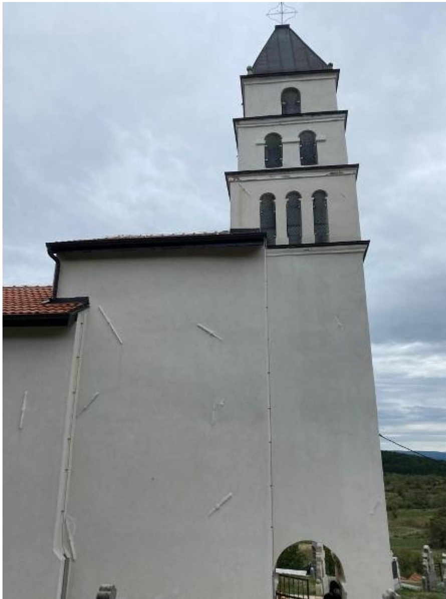
Prilog 30. Zatege koje izlaze iz zidne mase, slikano sa sjeverne strane crkve, foto: Dolores Perković
