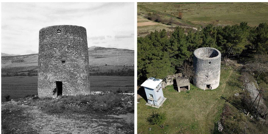
Slika 3-4. Kulina u Kaštel Žegarskom tijekom 1960-ih i 2020. godine (Konzervatorski odjel Zadar; snimio I. Kulenović)
