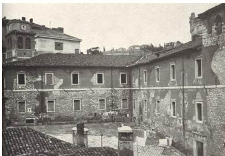
Slika 131. Zgrada nekadašnjeg kolegija , oko 1930. (preuzeto iz Vanino M. (1987.)
