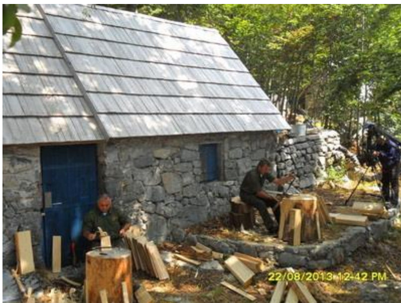
Slika 4. Izrada drvene šindre
