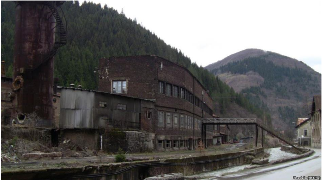
Slikovni prilog 2. Fotografija nekadašnje tvornice i djela gradilišta.
