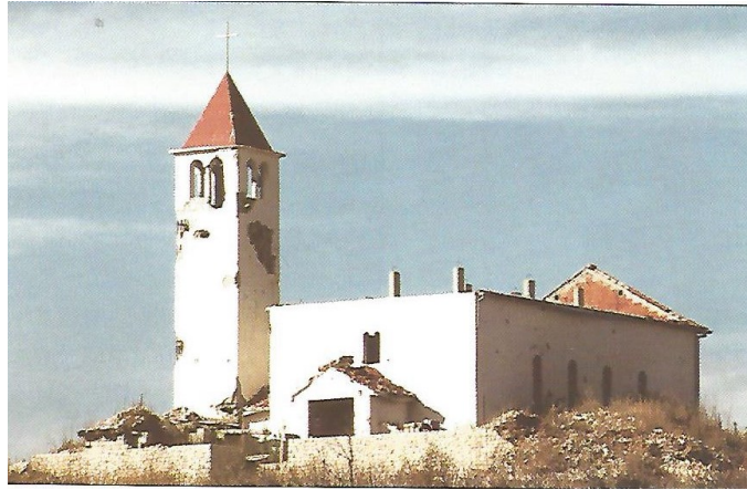
Slika 30. Podgradina- Župna crkva sv. Duha. (Ranjena crkva u Hrvatskoj, 1996: 296).
