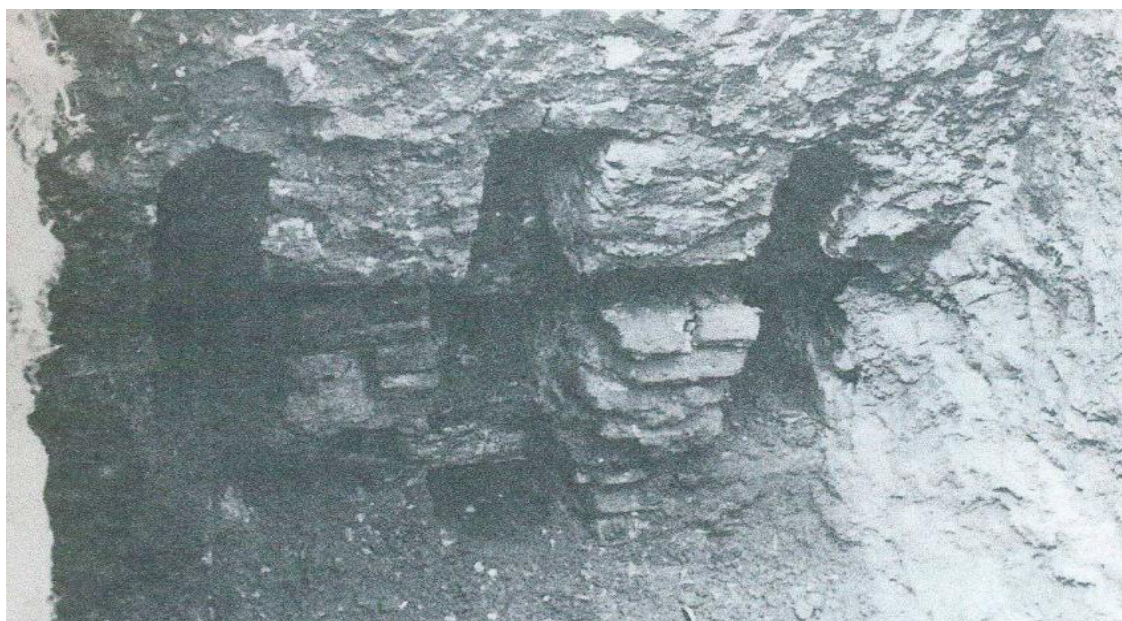
Slika 17. Prikaz otvora na istočnom zidu kule (Preuzeto iz: J. VIŠNJIĆ, T. PERCAN, 2015, 12.)
