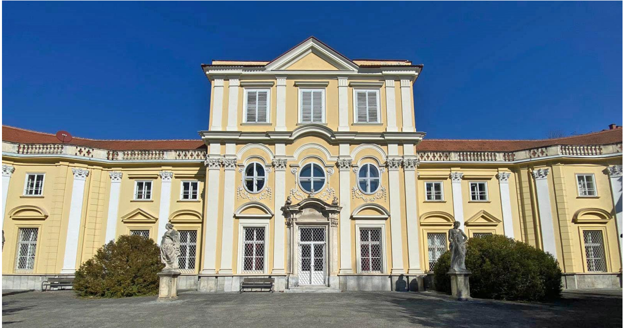
Slika 15. Meerscheinschlössl, Graz, 1689. – 1694., vrtna strana (foto: A. Laznibat)
