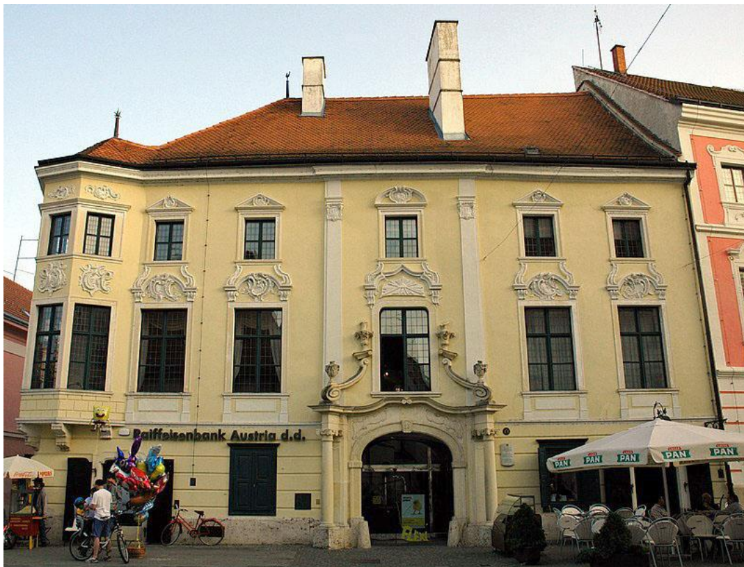
Slika 26. Palača Patačić, Varaždin, 1669. – 1764. , sjeverno pročelje
