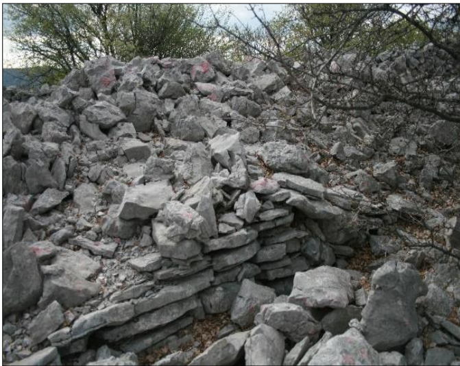
Sl. 247. Segment bedema gradine iznad Šućura (foto: T. Tomas)
