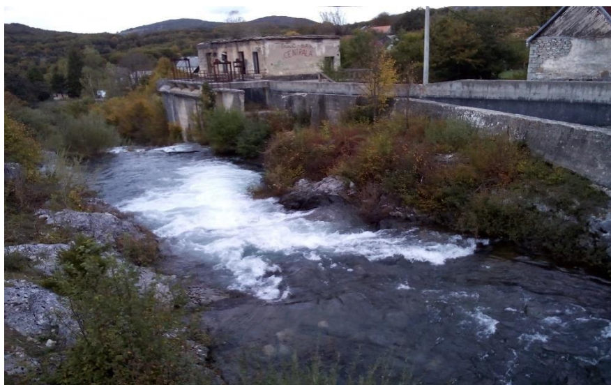
Izvor: Picture 1449 Hidrocentrala u Švici Vlastiti izvor
