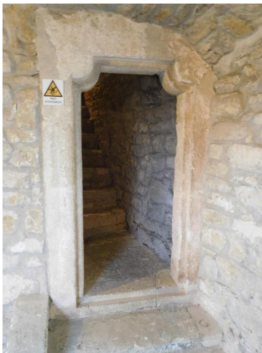
Slika 23: Varaždin, Stari grad – potkovasta kula, kameni okvir vrata (fotografija: Ivana Peškan)
