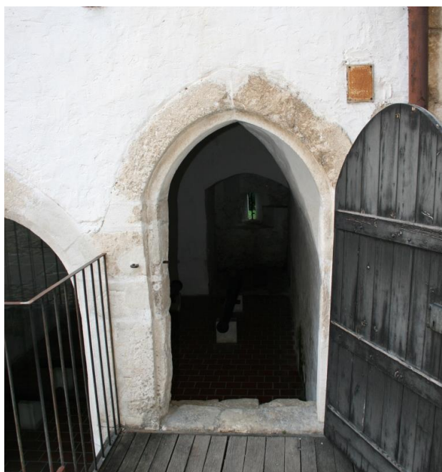
Slika 9: Varaždin, Stari grad – sjeverna kvadratna kula, kameni okvir vrata (fotografija: Ivana Peškan)
