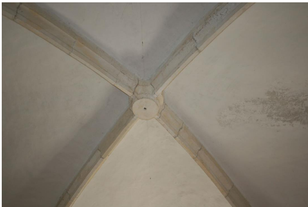
Slika 10: Varaždin, Stari grad – južna kvadratna kula, križni svod (fotografija: Ivana Peškan)
