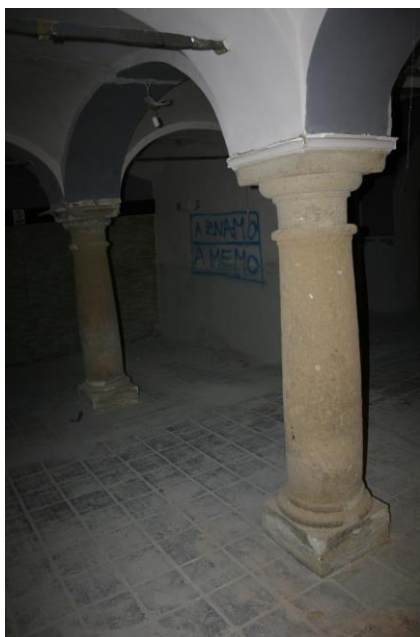
Slika 39: Varaždin, Franjevački trg 2 – toskanski stupovi u podrumu (fotografija: Ivana Peškan)
