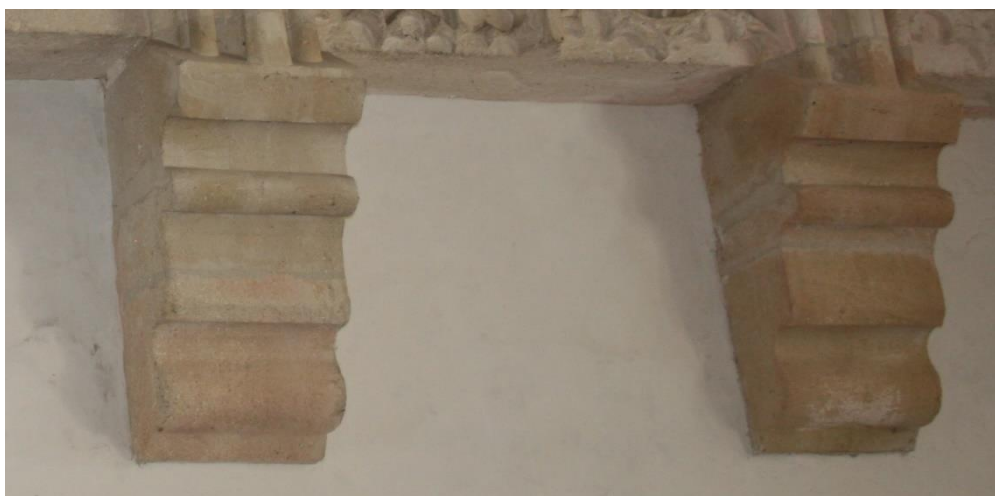
Slika 19: Varaždin, Stari grad – južna kvadratna kula, kamene konzole (fotografija: Ivana Peškan)
