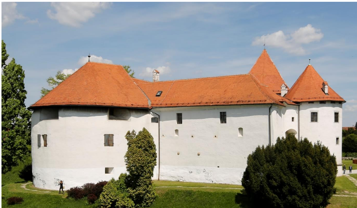
Slika 82 Varaždin, Stari grad, pogled na zapadno pročelje (fotografija: Ivana Peškan)
