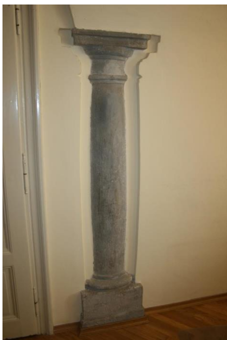
Slika 35: Varaždin, Gradska vijećnica – toskanski stup na katu (fotografija: Ivana Peškan)
