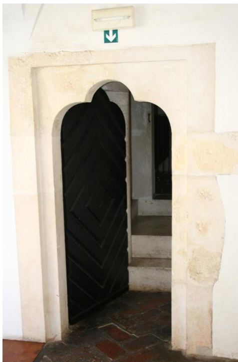
Slika 16: Varaždin, Stari grad – južna kvadratna kula: kameni okvir vrata, prvi kat (fotografija: Ivana Peškan)
