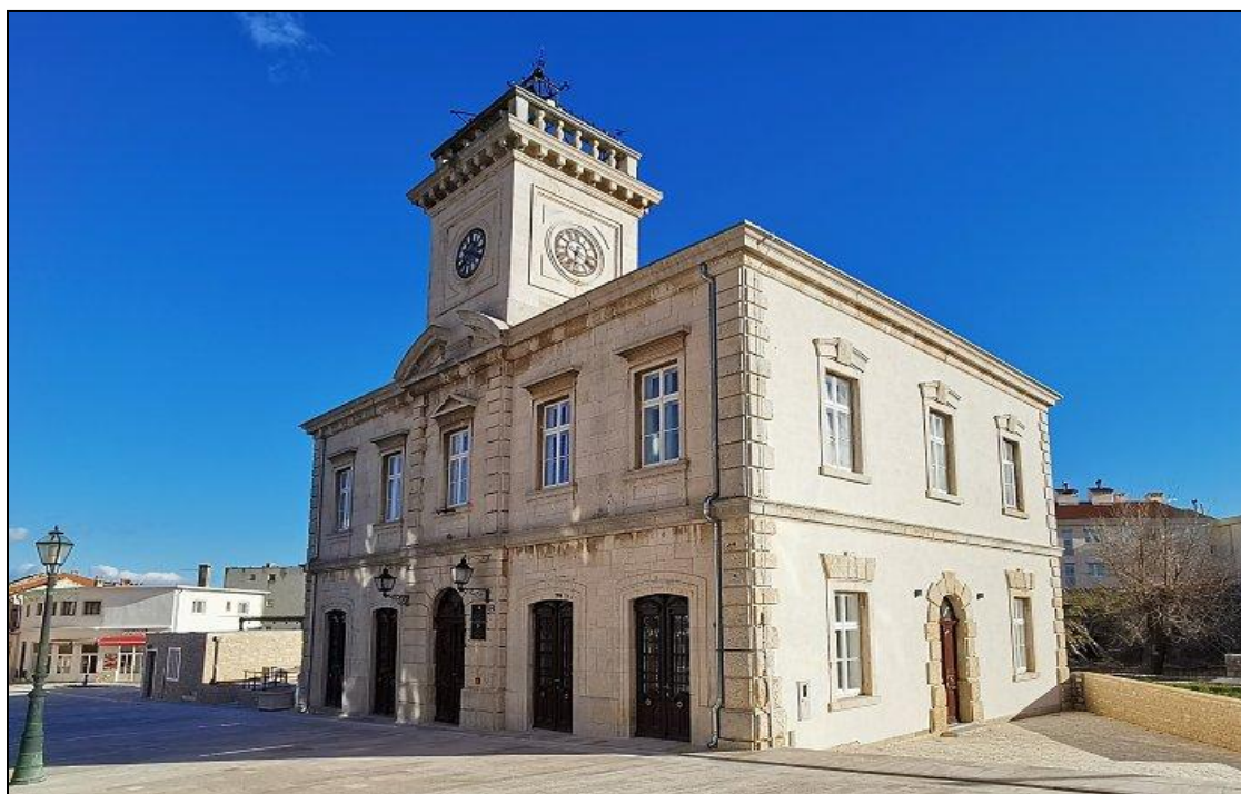
Prikaz 18. Benkovac, zgrada gradske uprave
