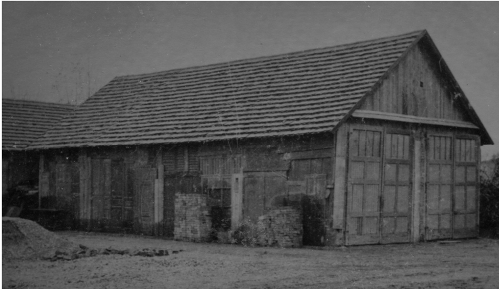
Sl. 42. Prva zgrada Gipsoteke u Bednjanskoj ulici 23, 1937. godine, Fototeka Gliptoteke HAZU, inv.br. F-21
