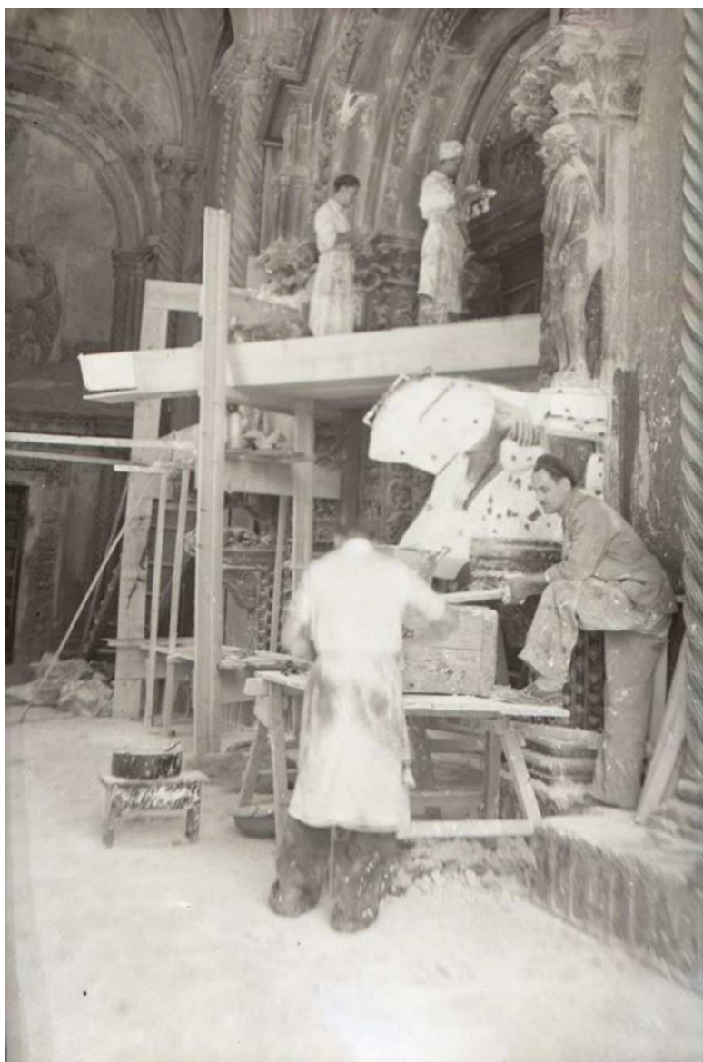
Sl. 78. Lijevanje Radovanovog portala u Trogiru 1940., Fototeka Gliptoteke HAZU
