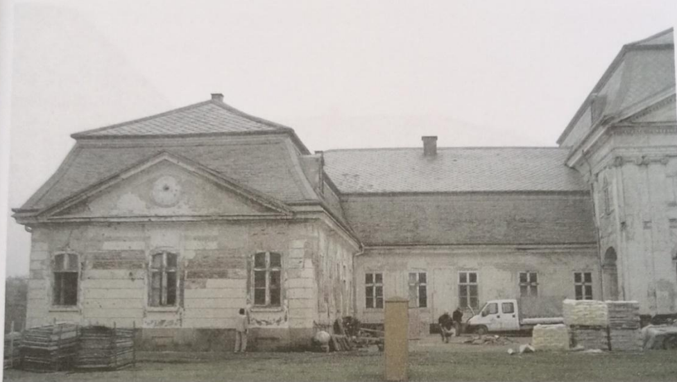
Sjeverno pročelje istočnog krila
