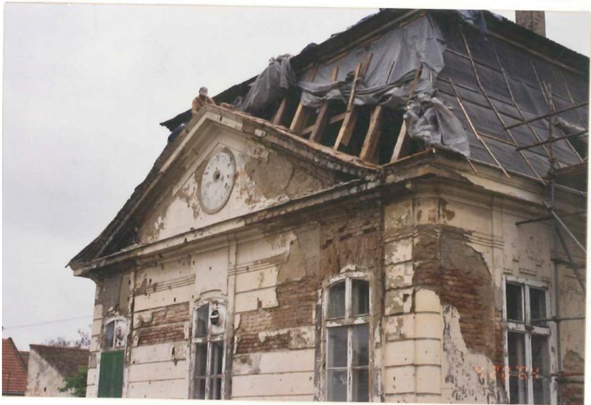
Slika 26. Radovi na rekonstrukciji mansardnog krovišta nad istočnim krilom, izvor: MK-UZKB-KOS
