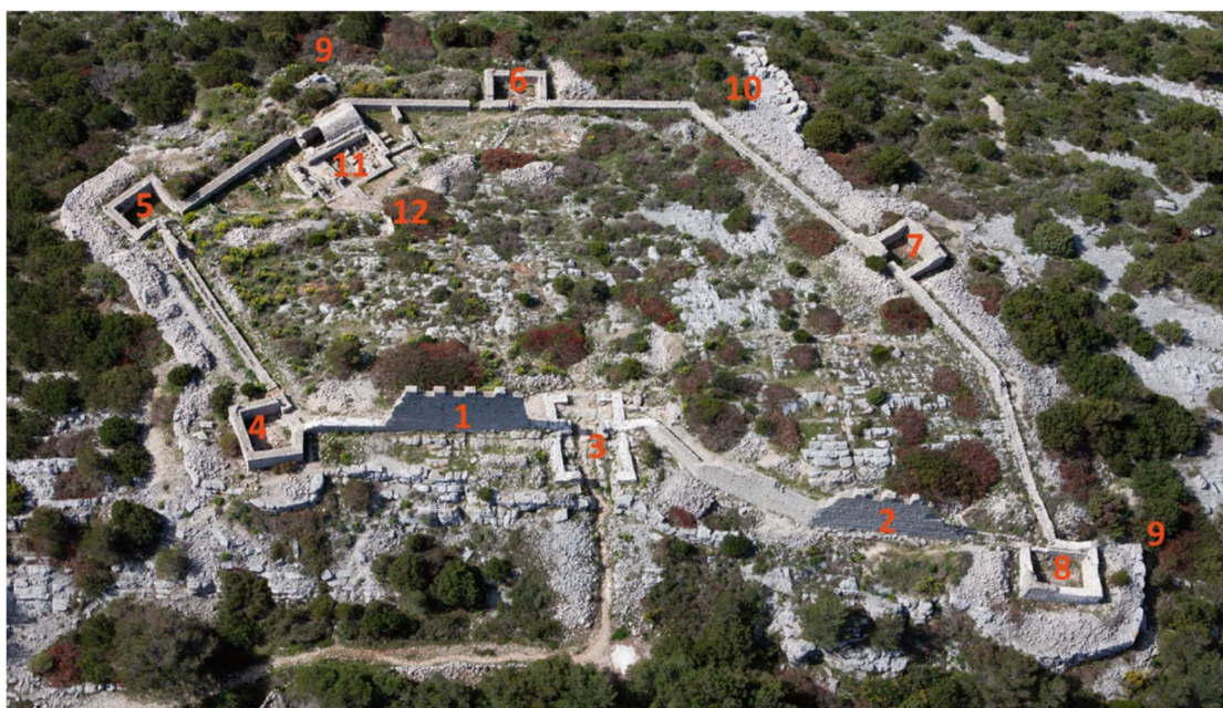
Slika 2. Zračni snimak Gradine na otoku Žirju: 1) segmenti unutrašnjeg bedema s kruništem jugoistočno i 2) sjeverozapadno od glavnog ulaza; 3) glavni ulaz u utvrdi – propugnaku; 4) sjeveroistočna kula; 5) jugoistočna kula; 6) jugozapadna kula; 7) zapadna kula; 8) sjeverozapadna kula; 9) završeci vanjskog bedema - proteihizme; 10) skupina kamenih blokova kod jugozapadnog kuta utvrde; 11) stambeni sklop; 12) jama s vodom (Slika i opis preuzeti iz E. PODRUG et al., 2016, 63)
