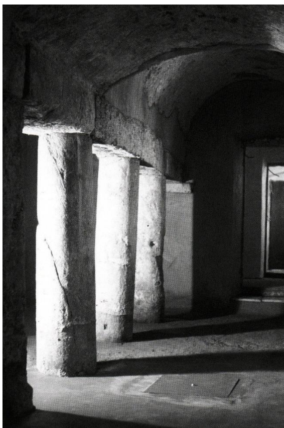
1. Stupovi i presvođena unutrašnjost cisterne do katedrale u Zadru (P. Vežić, 1980.)
