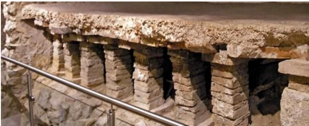
Slika 13: Ostatci podnog grijanja
