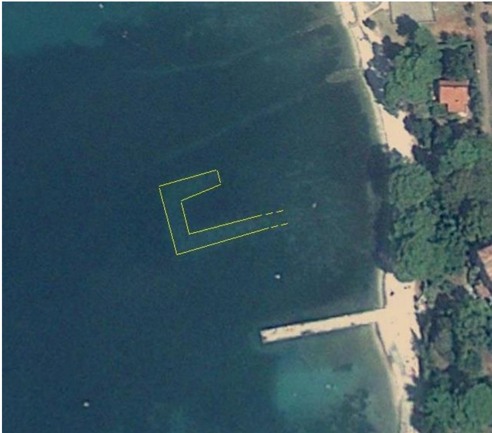
Sl. 27. Izlomljeni lukobran na rtu Mede.
