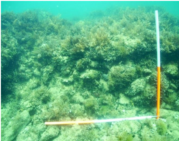
Sl. 32. Uvala Kocište. Kamenomet na čelu lukobrana.
