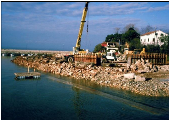
Sl. 42; Sl. 43. Građevinski radovi iz 1995. godine. Kameni blokovi koji su razidani od strukture operativnogpristaništa na sjevernoj obali luke (lijevo) i izgradnja betonske posteljice (desno) iznad koje su metodom anastilozе ugrađeni isti kameni blokovi (fotografije ustupio prof. dr. Z. Brusić)
