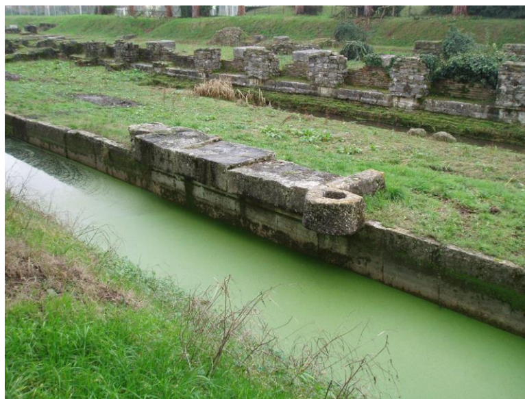
Sl. 13. Aquileia, zapadno lice operativne obale na istočnom dijelu grada: mjesto za privezivanje brodova i ostaci temelja skladišta u pozadini (foto: I. Koncani Uhač)
