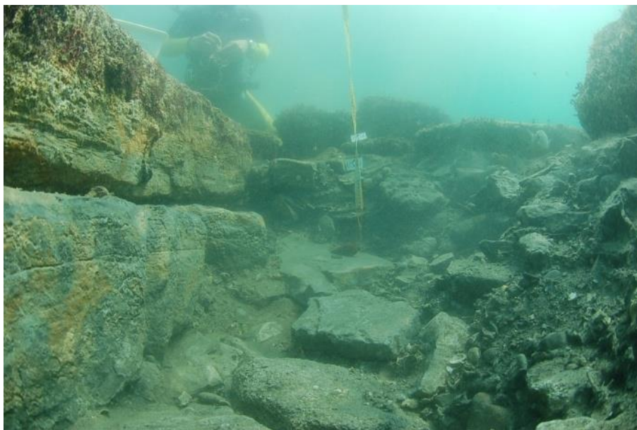
Sl. 161. Vanjsko lice unutarnjeg mula sa zapadne strane, sa dva reda sačuvanih blokova (foto: D. Gaddi)
