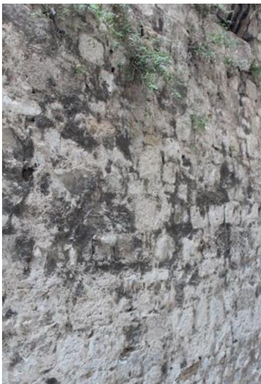
Prilog 20. Primjer zidanja lomljencem
