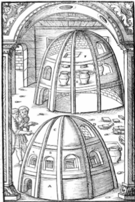
Sl. 7 - G. Agricola, De re metallica , 1556; drvorez s prikazom staklarske peći na tri razine i njegovim otvorima (Davison, S., 2006, 147.)
