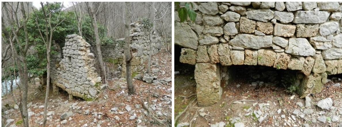
Slike 189 i 190: Pogled na staru mlinicu ispod Grada (foto: N. Čuljak).
