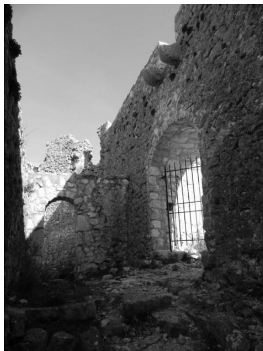
Slika 266: Ulaz u stari grad Ljubuški i konzole za mašikul, odnosno breteš ( bretèche ) iznad ulaza (foto: N. Čuljak).
