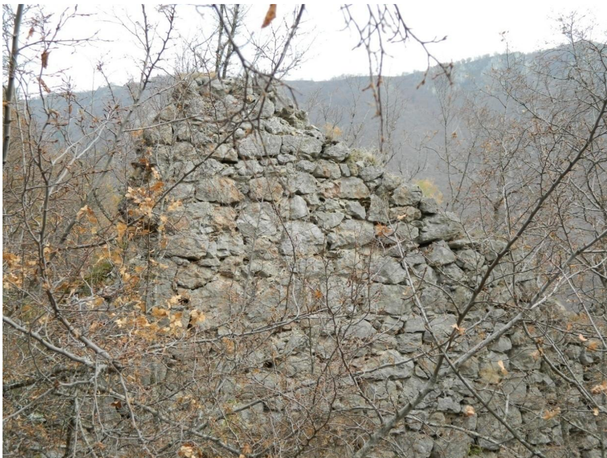
Slika 93: Pogled prema južnom dijelu zida gradske kapije - gledano iz prostora grada (foto: N. Čuljak).
