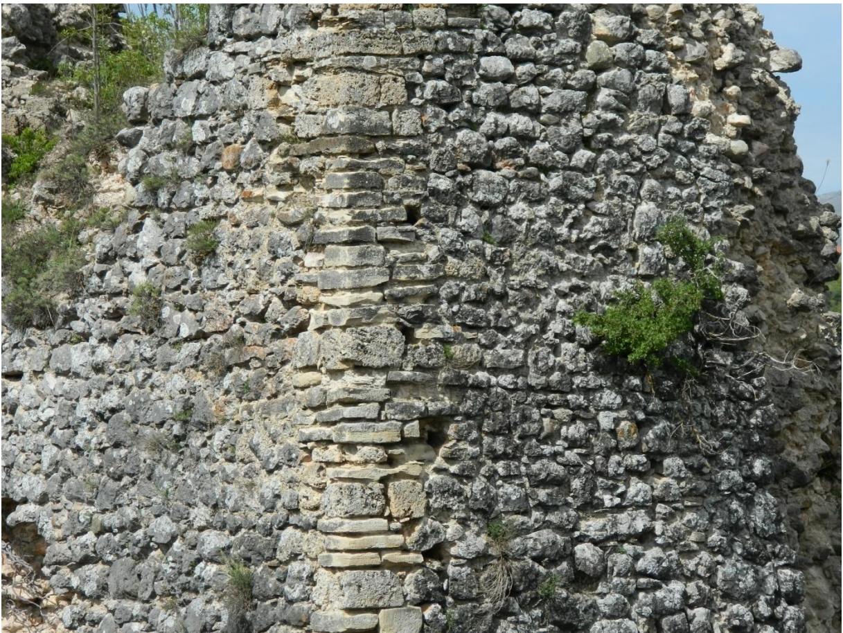
Slika 176: Detalj vanjskog zida kule (foto: N. Čuljak).
