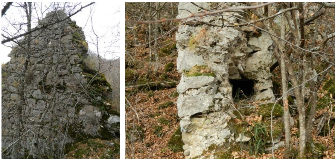
Slike 259 i 260: Ulaz u stari grad Črešnjevo (Trešnjevac) lijevo dio urušene vanjske gradske kapije, a desno drugi dio gradske kapije promatran s bočne strane (foto: N. Čuljak).
