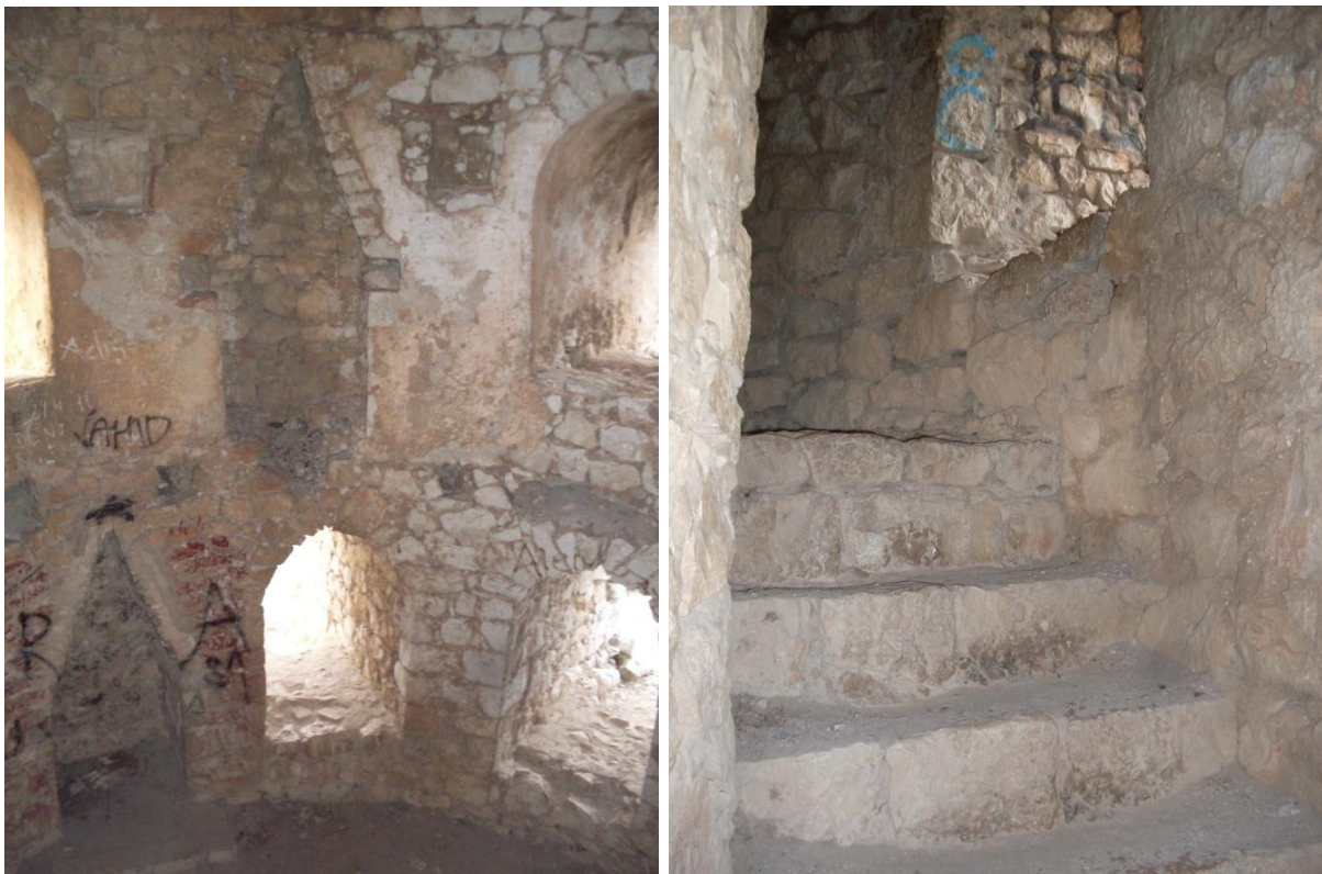
Slike 19 i 20: Pogled na unutrašnjost počiteljskog donžona: lijevo su kamini na različitim katovima i topovski otvori, desno je kružno zidano stepenište unutar kule (foto: N. Čuljak).
