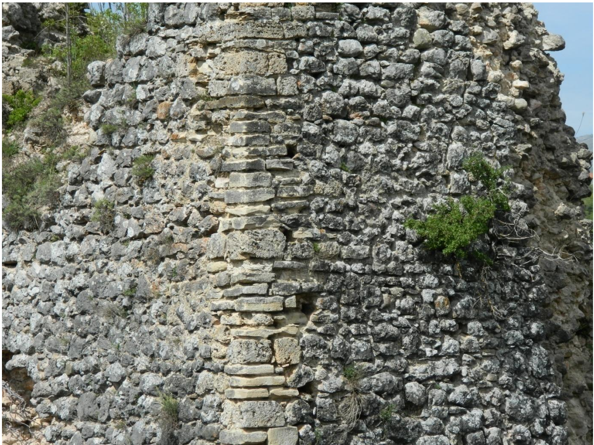
Slika 176: Detalj vanjskog zida kule (foto: N. Čuljak).
