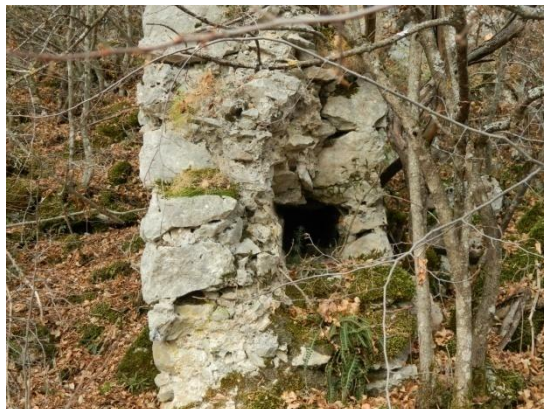
Slika 94: Četvrtasto udubljenje u zidu gradske kapije – dio sustava zatvaranja (foto: N. Čuljak).
