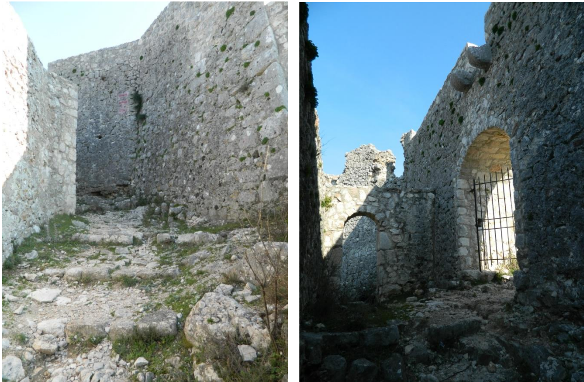
Slike 122 i 123: Prilaz gradu – ostatci kaldrme i desno ulaz u grad sa konzolama od breteša - bretèche (foto: N. Čuljak).
