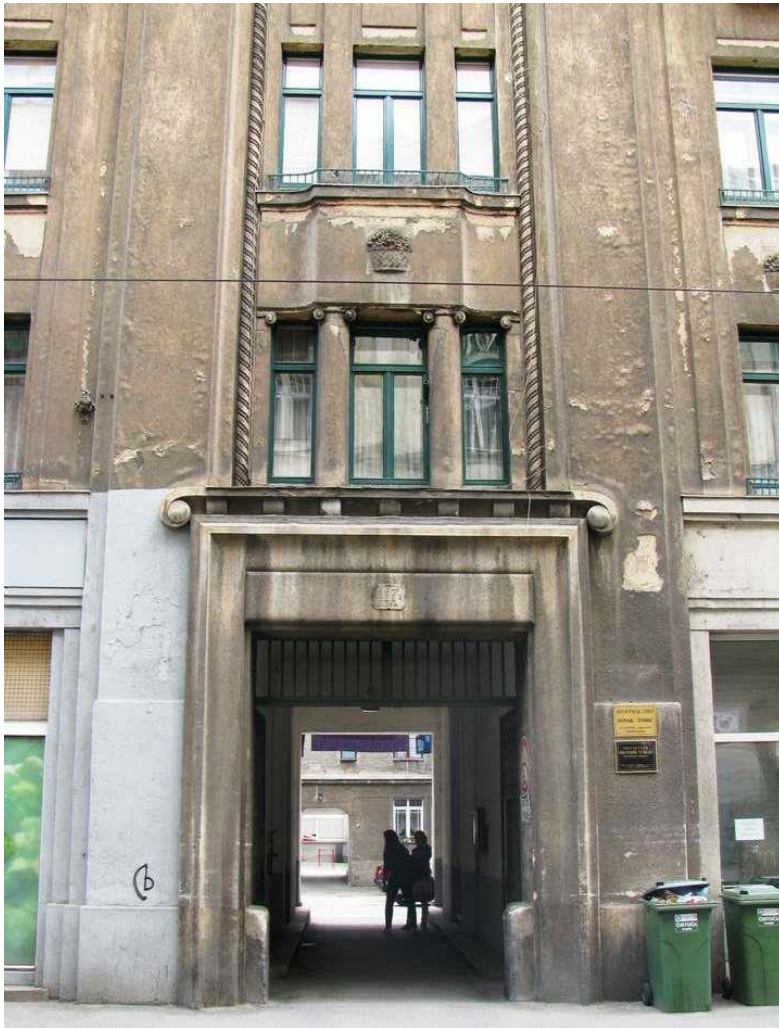
505. Zgrada Prve hrvatske štedionice (Zagreb, Ilica 117-117 A), detalj pročelja - ulaz (foto: M. Strugar, 2013.)
