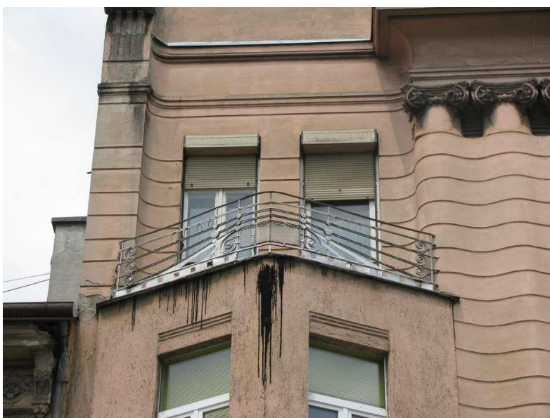
386.-388. Detalji pročelja zgrade Goršak (foto: M. Strugar, 2013.)
