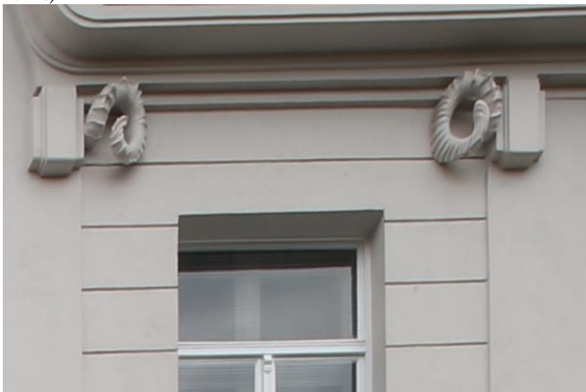
134. Zgrada Goršak (Zagreb, Ilica 166), ovnujski rogovi na pročelju (foto: Z. Bogdanović, 2015.)
