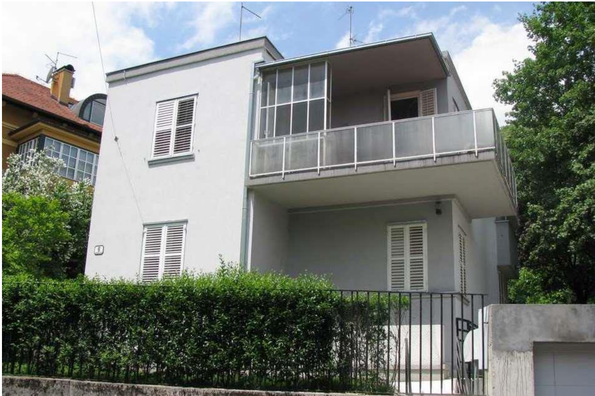
124. Vila Defour-Radošević (Zagreb, Buconjićeva 6), pogled prema uličnom pročelju (foto: M. Strugar, 2012.)
