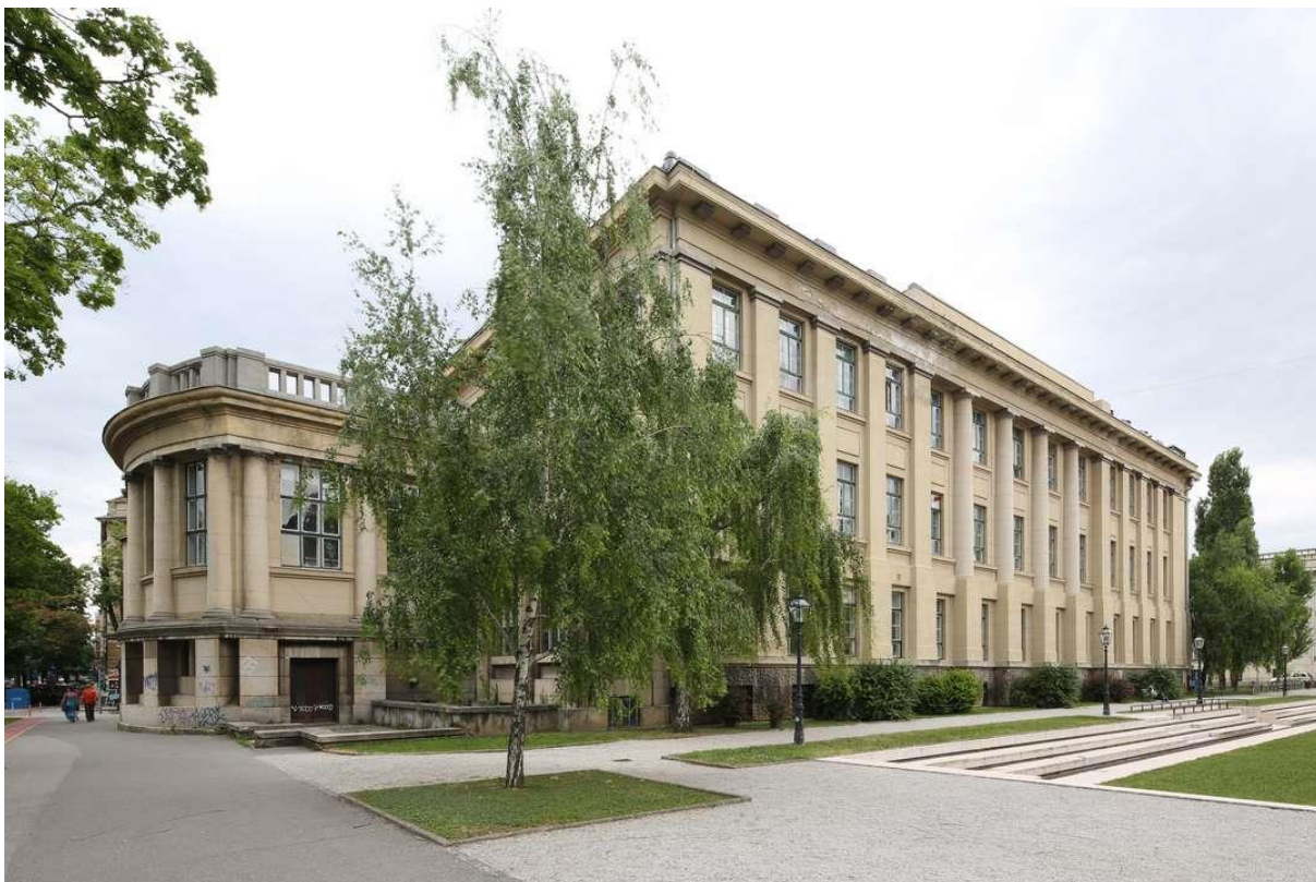
447. Kraljevski sveučilišni ludžbeni zavod (Zagreb, Marulićev trg 20), pogled sa sjeverozapada (foto: Z. Bogdanović, 2015.)
