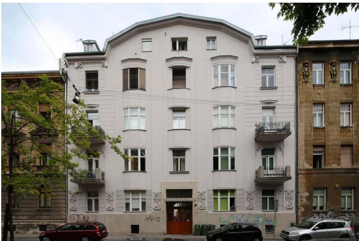
80. Zgrada Hodovsky (Zagreb, Gajeva 47), ulično pročelje (foto: Z. Bogdanović, 2015.)
