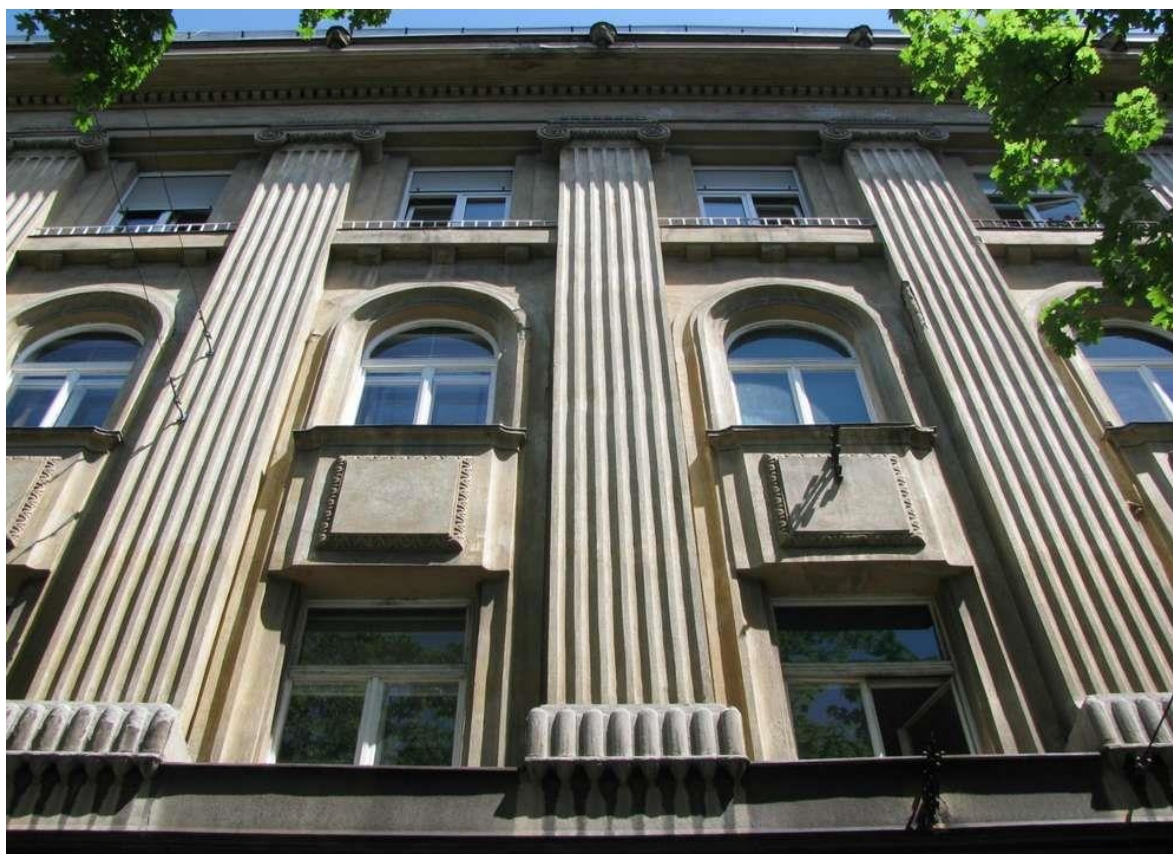
495. Ulično pročelje, detalj (foto: M. Strugar, 2013.)
