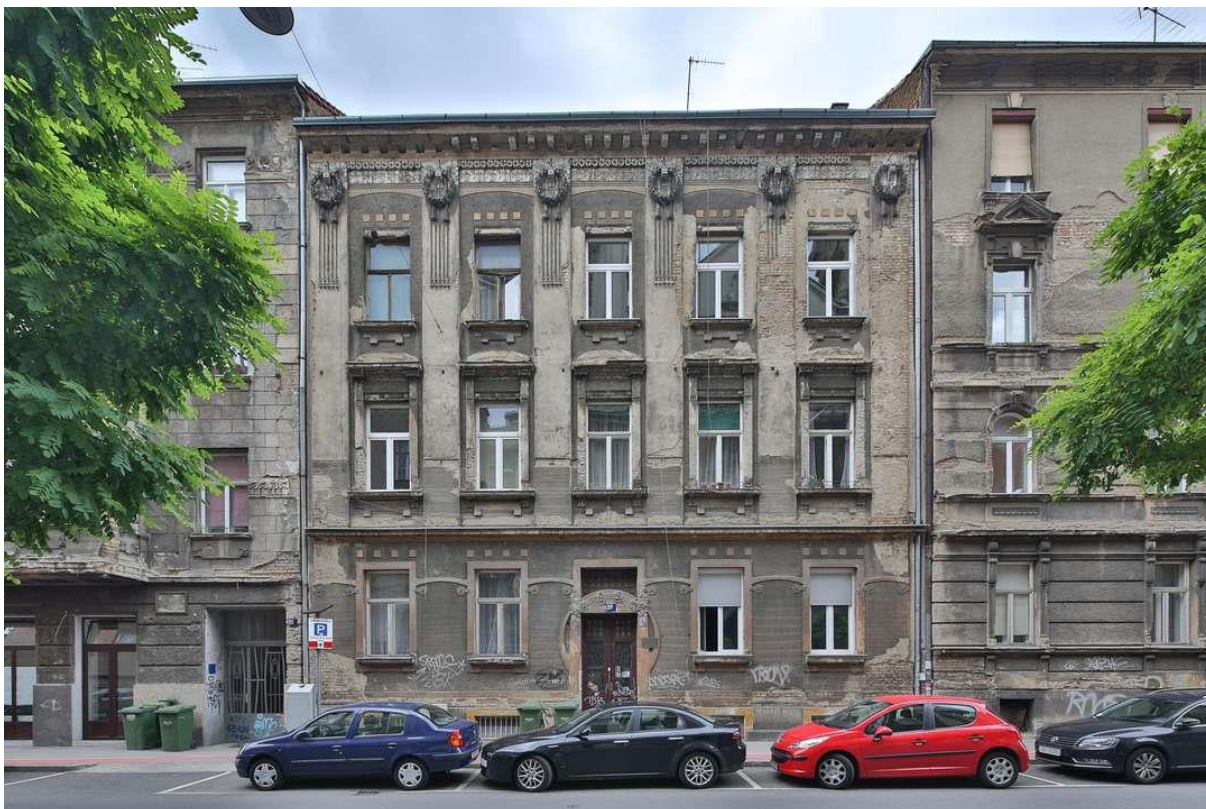
254. Zgrada Majdak (Zagreb, Palmotičeva 50), ulično pročelje (foto: Z. Bogdanović, 2015.)
