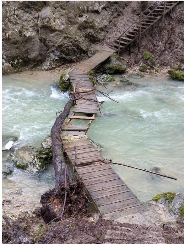
Slika 25. Bujičnim tokovima uništen most preko kanjona Pazinčice (preuzeto iz Labinjan, 2016)
