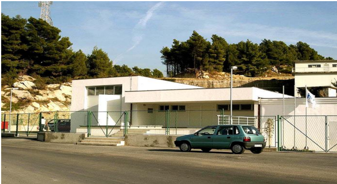
Slika 22: Crpna stanica Kunčeva greda koja opskrbljuje Solin, Kaštela i Trogir ( Izvor: URL11 ).
