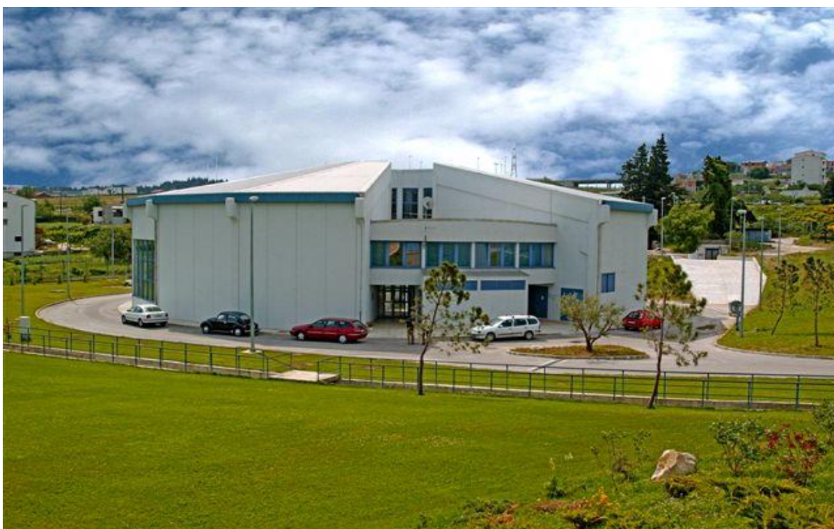
Slika 23: Crpna stanica Ravne njive koja opskrbljuje Split ( Izvor: URL11).
