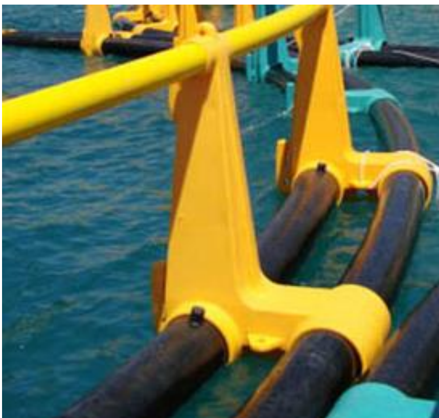
Slika 8. Stoper i držač HDPE cijevi tzv. „bracket“ (Izvor: www.pensito.hr )
