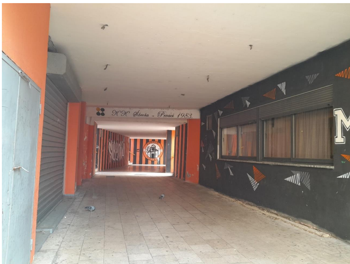
Slikovni prilog 5. Unutrašnjost pothodnika. Autorica fotografije Ana Madunić. Šibenik, travanj 2023.
