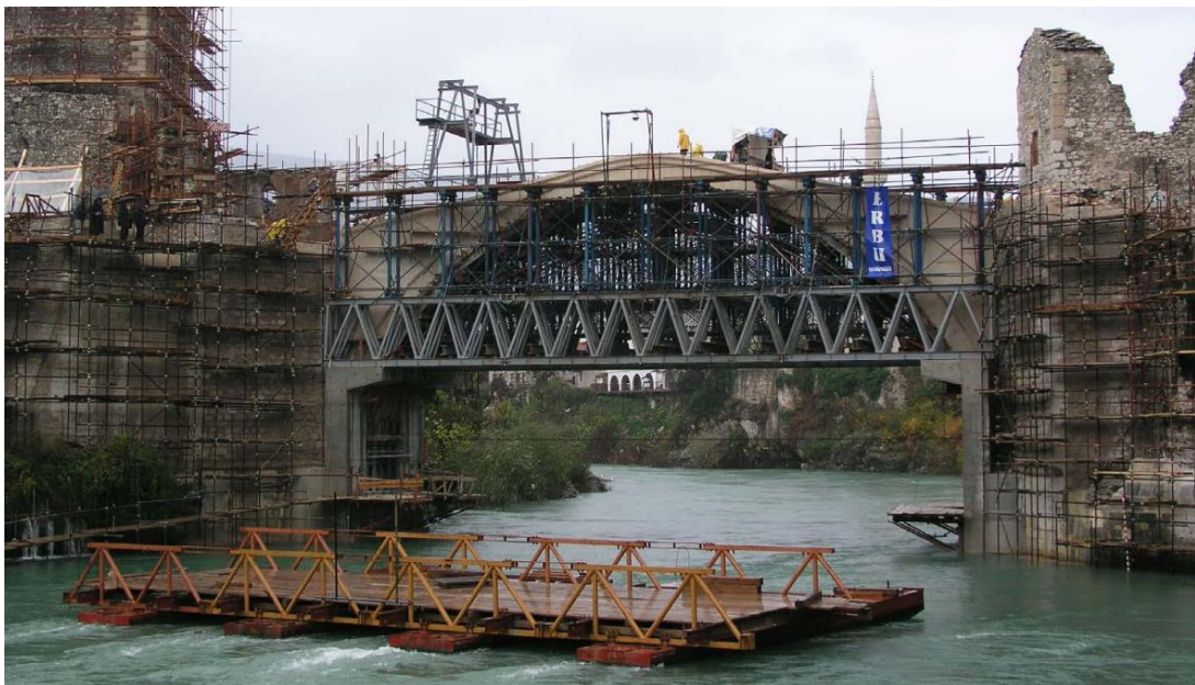
Slika 12. Konstrukcija skele tijekom obnove Starog mosta (Izvor: M. Glibić, Priče o Starom mostu, 2018., 44)
