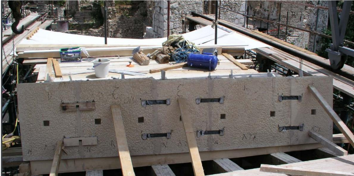
Slika 13. Pripremljeni kameni blokovi za zidanje luka Mosta (Izvor: M. Glibić, Priče o Starom mostu, 2018., 48)
