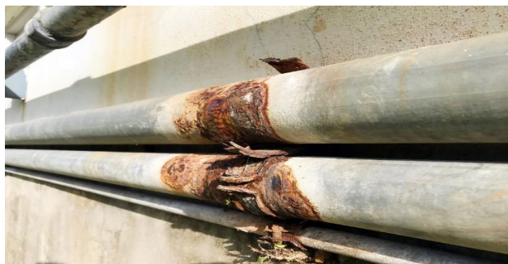
Slika 13. Zahrđalost cijevovoda (Izvor: https://www.blog.eddyfi.com )
