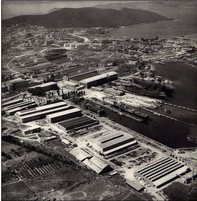
Slika 6. Izgled brodogradilišta za vrijeme francuske Uprave
