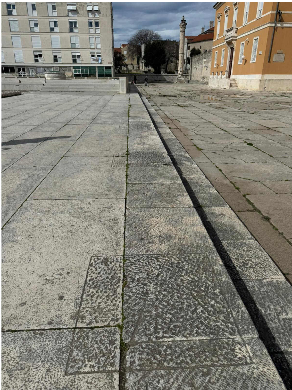
Slika 17. Tragovi baza stupova južne kolonade na gornjoj rubnoj stepenici
