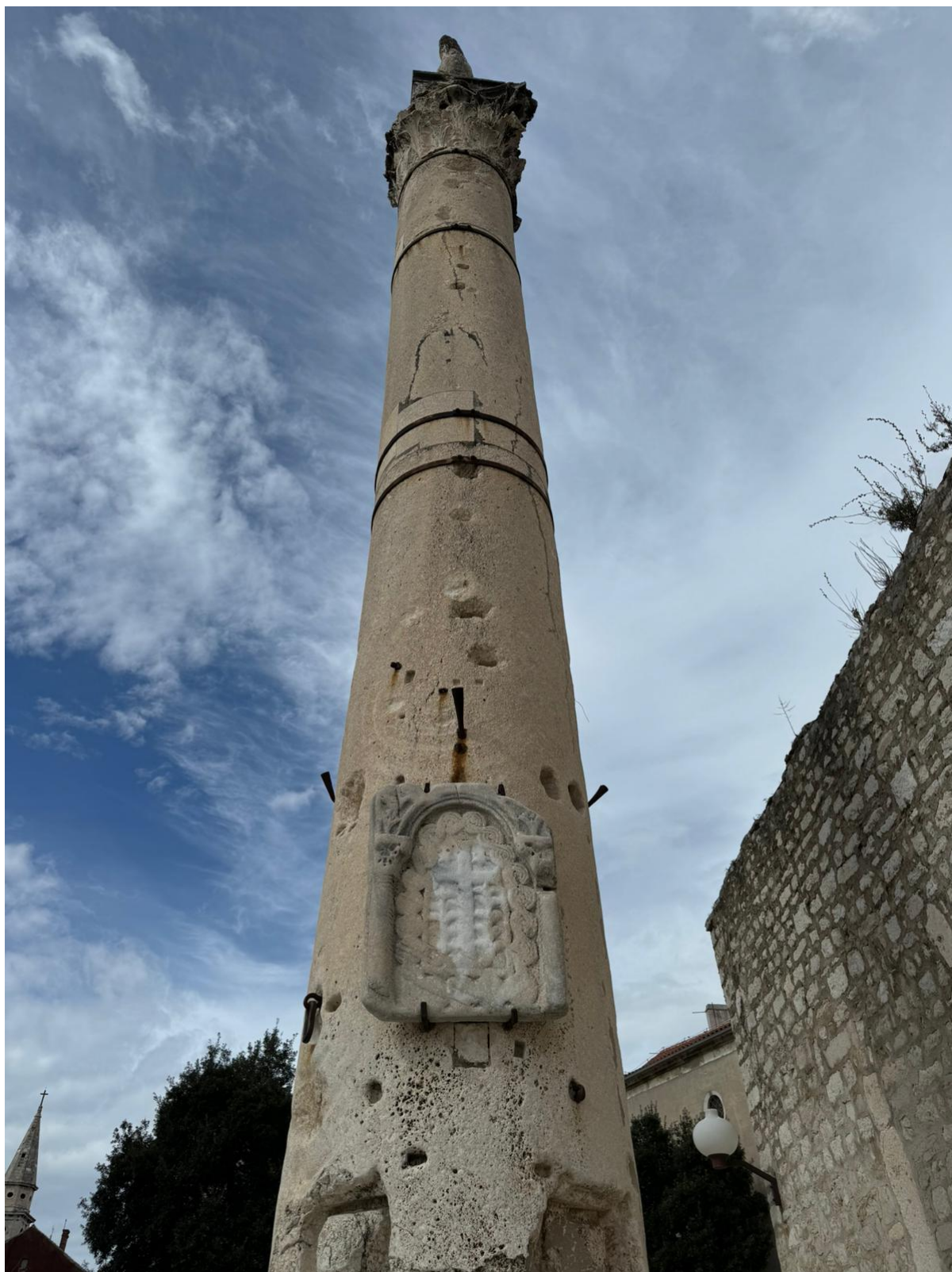
Slika 25. Prikaz trupa kolone i ugradbena mramorna ploča s prikazom latinskoga križa
