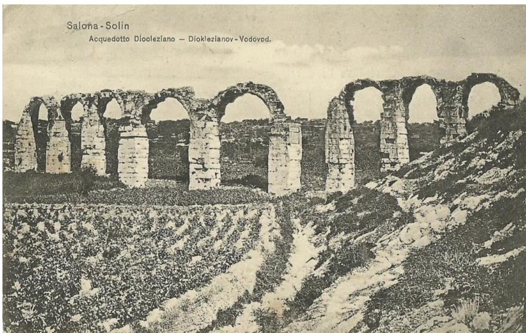
Sl. 43. Dioklecijanov vodovod u Dujmovači prije obnove, oko 1870. (prema: Zavičajna zbirka Gradske knjižnice Marka Marulića, Split)
