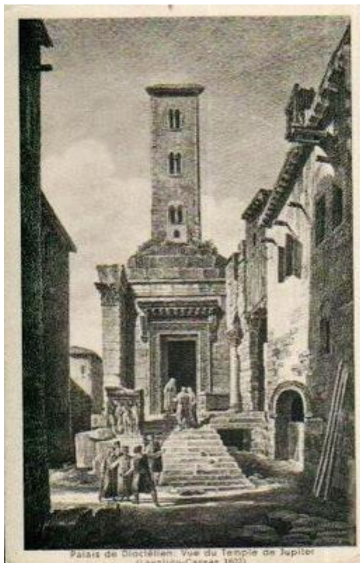
Sl. 56. Zvonik nad Malim hramom (Prema: Marasović, T. – Zaštita graditeljskog
