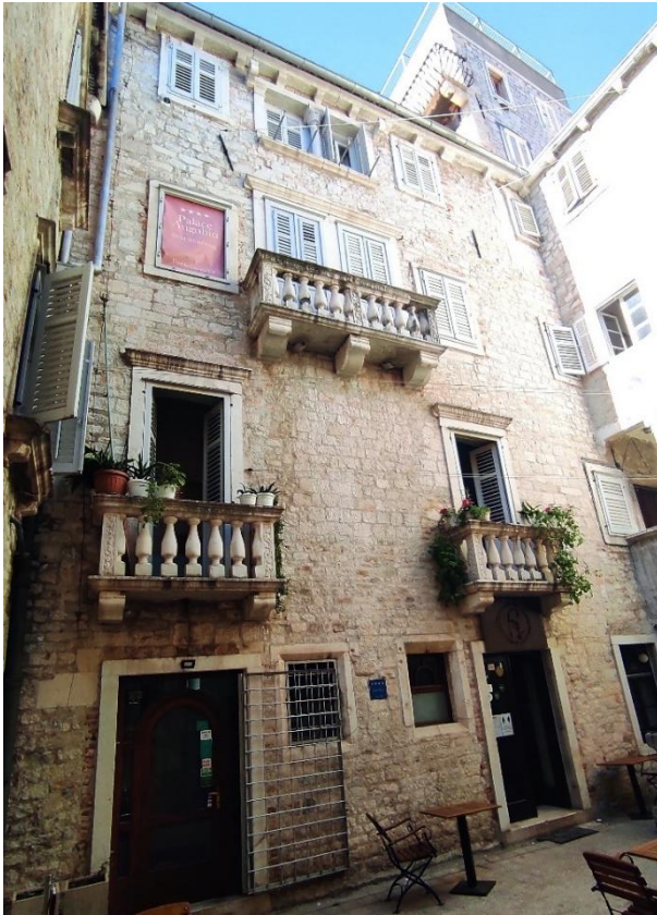
Slika 123. Zapadno dvorišno pročelje palače Augubio, Split
