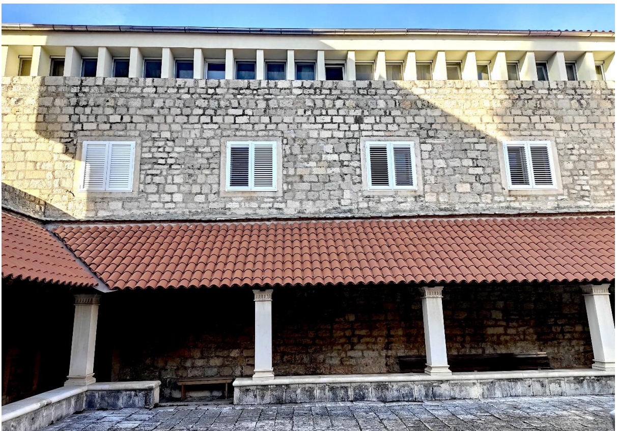
Slika 84. Nadogradnja sjevernog samostanskog krila
