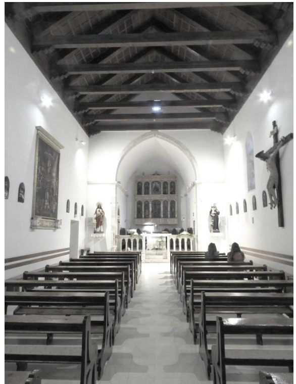
Slika 26. Drvena stropna konstrukcija poljudske crkve
