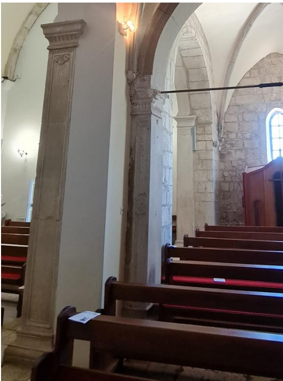
Slika 142. Detalji arhitektonske plastike crkve franjevačkog samostana Gospe od Milosti u Hvaru
