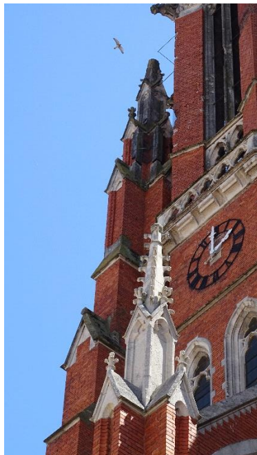
Prilog 18. Obnovljeni i neobnovljeni detalji konkatedrale na sjevernom pročelju. Autor fotografije: Karla Buzinac.
