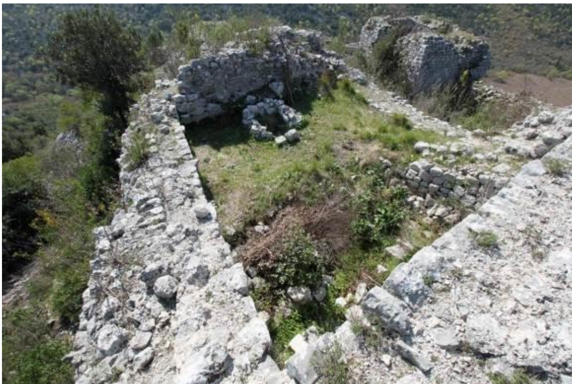
Slika 134. Vrtar – unutrašnjost glavne kule
