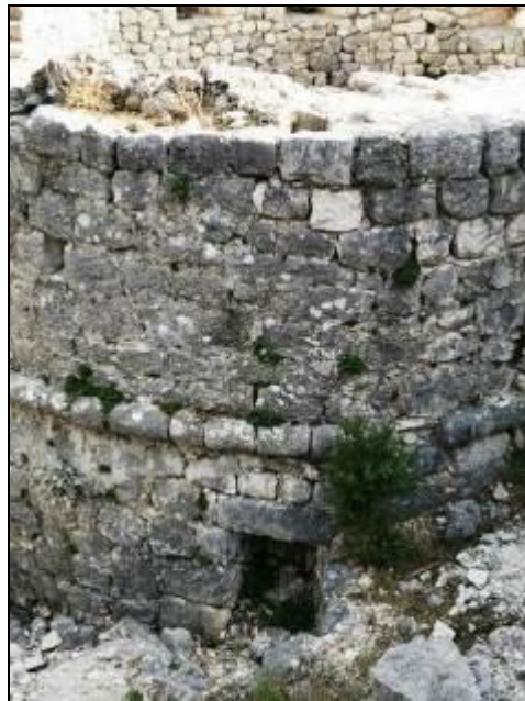
Slika 104/105 Zadvarje, ojačanje sjvernog bedema i otvor zahoda u sz kuli
