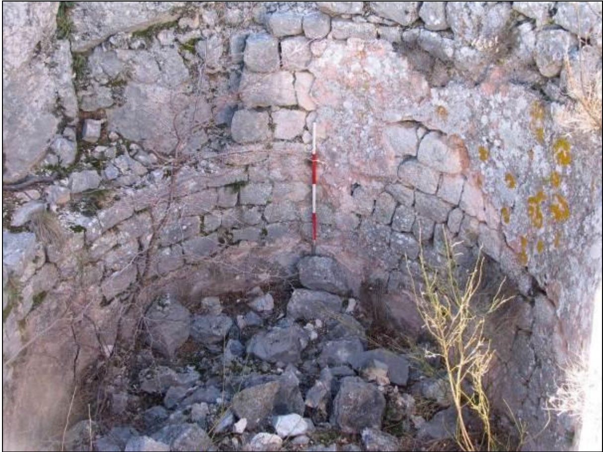
Slika 92. Proložac – Badnjevice, cisterna za vodu
