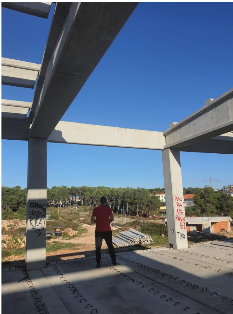
Slika 14 Napuštena višekratna zgrada
