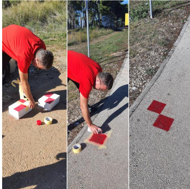
Slika 6 Označavanje orijentacijskih i kontrolnih točaka
