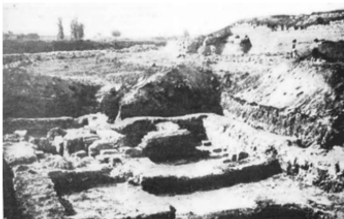
Sl. 78. Zgrada s hipokaustom ispod južnog perimetra kompleksa, poslije zatrpavanja; iz dokumentacije C. Patscha (preuzeto: Bojanovski, 1969a, 46)
