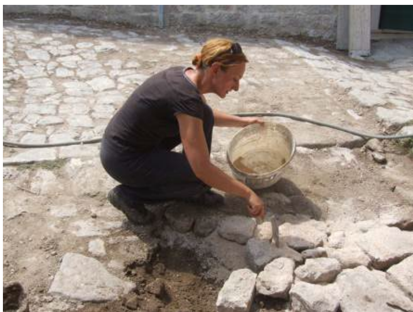
Sl. 224. Postupak vraćanja kamena na stazu i uranjanje kamena u kamenu nulu
