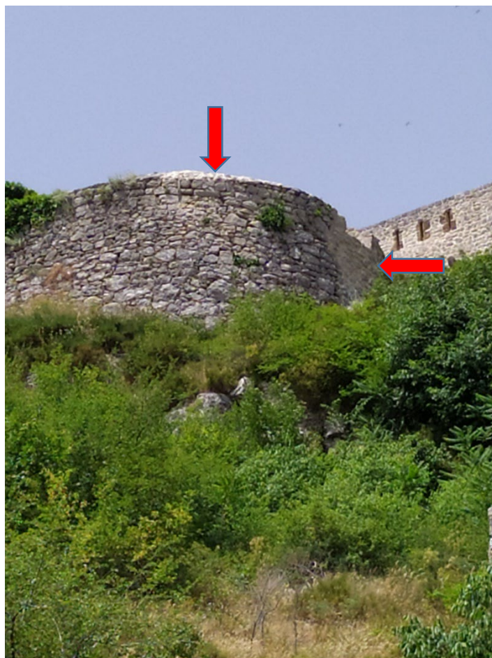
Sl. 230. Radovi konzervacije na bastionskoj kružnoj kuli Topani.
