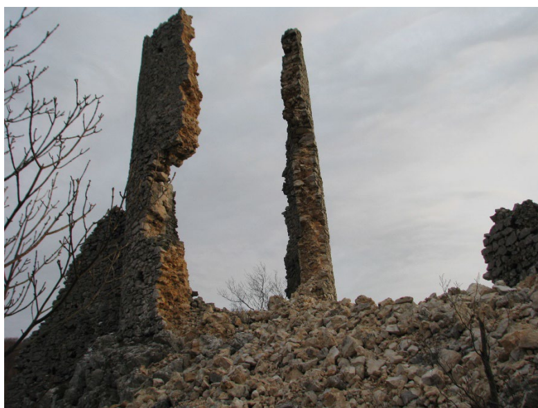
Sl. 372. Pogled na ostatke zidova kule na sjeverozapadu utvrde (17. studenoga 2015.)
