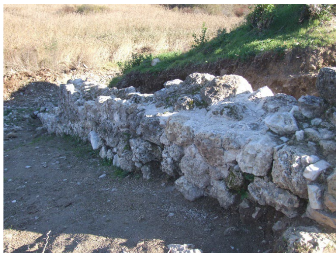
Sl. 187. Na ostatak obrambenog zida sa sjeveroistočne strane Kapitula stavljen je završni sloj žbuke kako bi se zid zaštitio od propadanja
