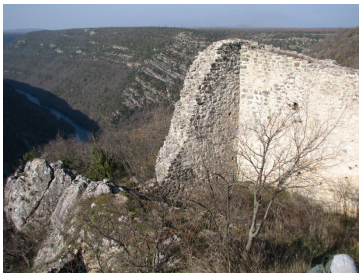
Sl. 299. Ostatak obrambenog zida na sjeveru i zapadu utvrde, snimljeno 23. veljače 2011. godine
