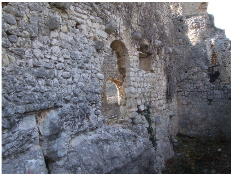
Sl. 54. Zid na sjeveroistočnoj strani prostorije s ulazom
