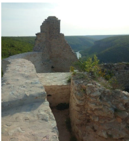
Sl. 327. Konzervirani zid na jugoistoku utvrde (foto: Anita Sičić Nadander, 2020.)
