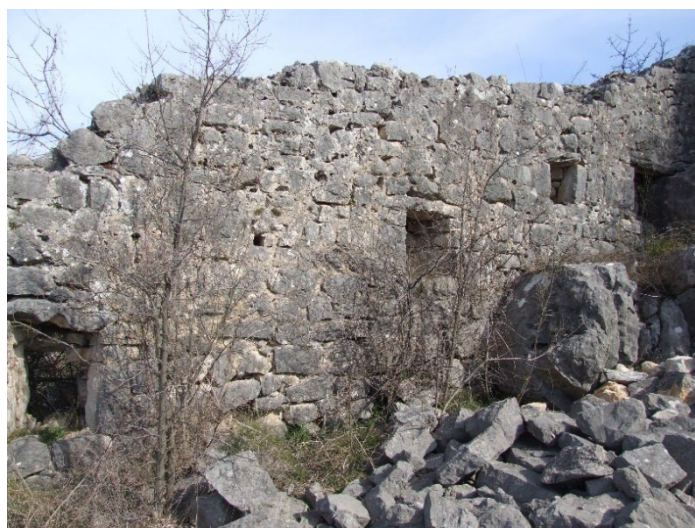
Sl. 283. Prozori na sjeverozapadnom obrambenom zidu utvrde, pogled s juga
