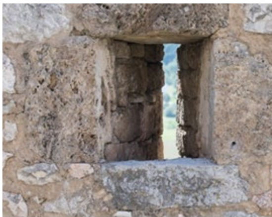
Sl. 471. Pogled kroz puškarnicu na Kninskoj tvrđavi (foto: Ante Šimić, 2020.)
