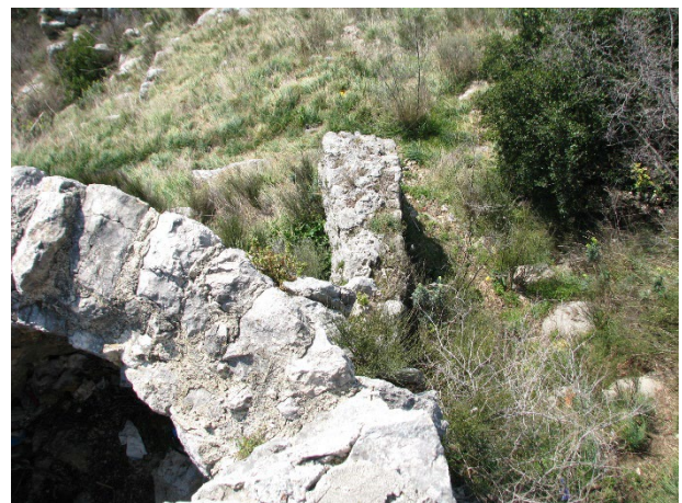
Sl. 23. Ostatak obrambenog zida u temeljnoj stopi
