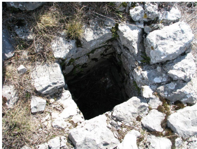
Sl. 351. Cisterna na utvrđi
