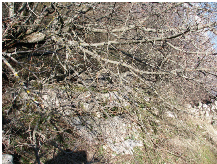
Sl. 408. Ostaci obrambenog zida na sjeveroistoku utvrde
