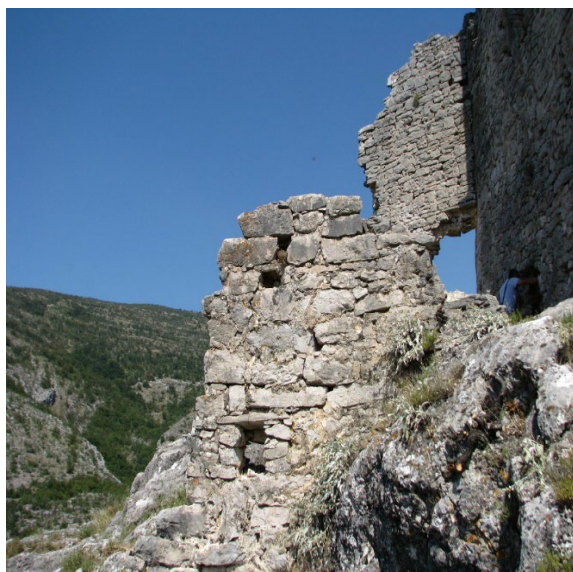
Sl. 76. Južni zid SJ 15 Prostorije 2
