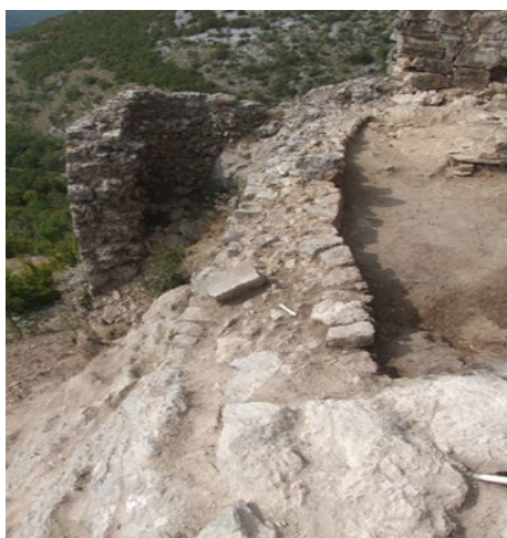
Sl. 126. Pogled s istoka na zid SJ 10 prije konzervatorskih radova
