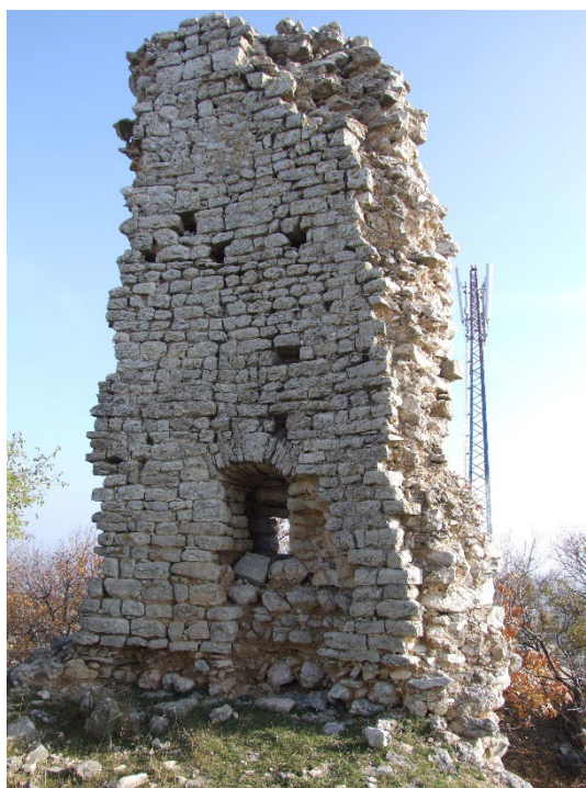
Sl. 163. Treći zid kule na jugoistoku utvrde
