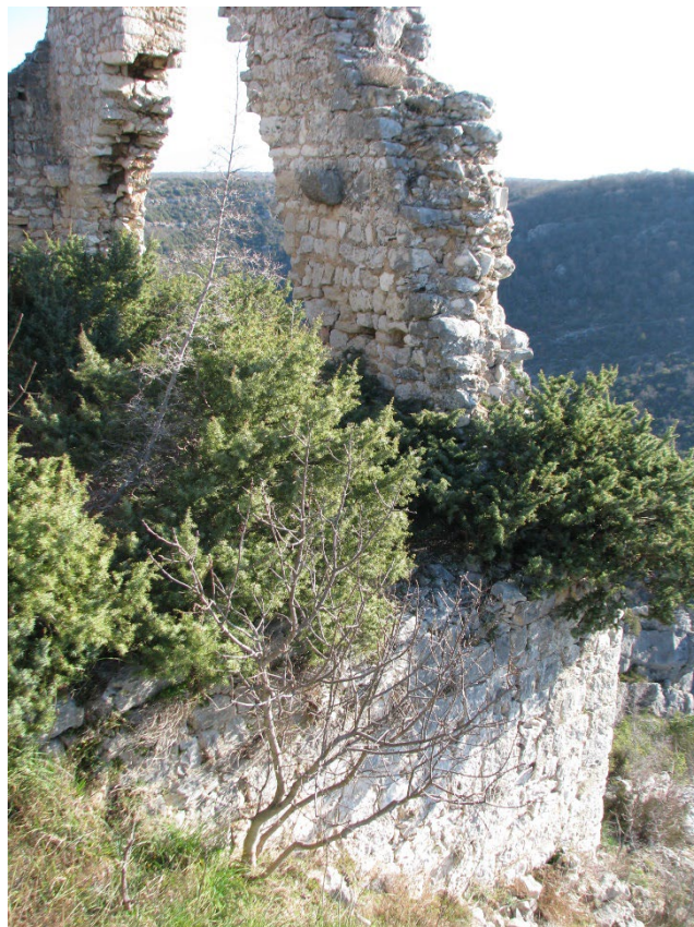
Sl. 141. Ostaci zgrade na sjeveroistoku utvrde
