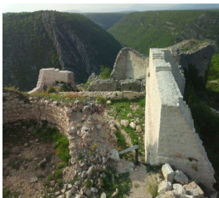
Sl. 324. Pogled na konzerviran zid na sjeveroistoku utvrde
