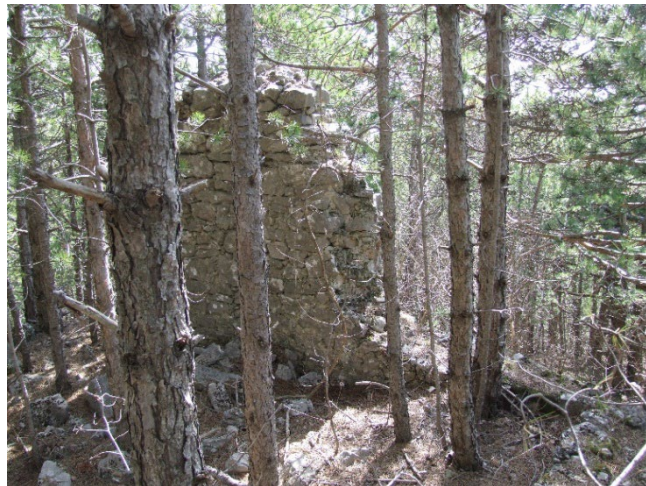
Sl. 335. Pogled na dio zida kružne kule na jugozapadu utvrde
