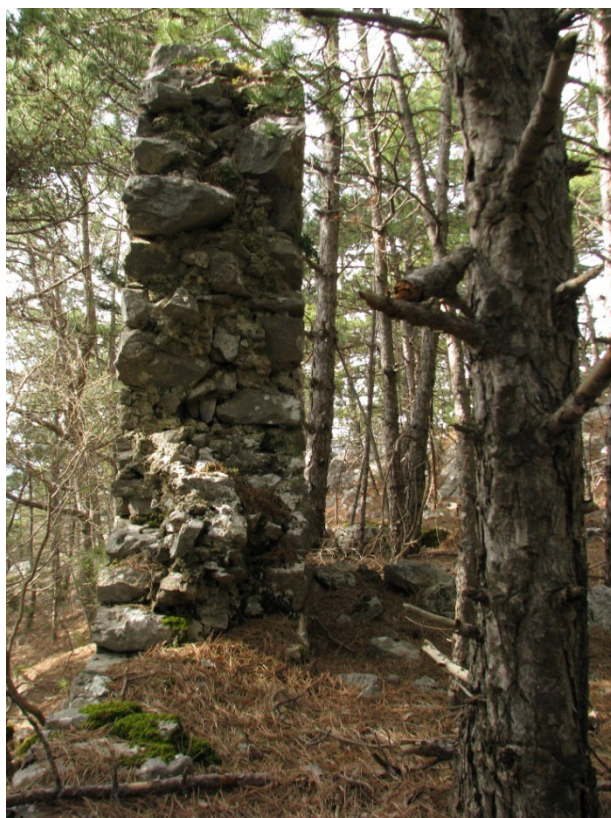
Sl. 333. Ostatak obrambenog zida prostorije na jugozapadu utvrde
