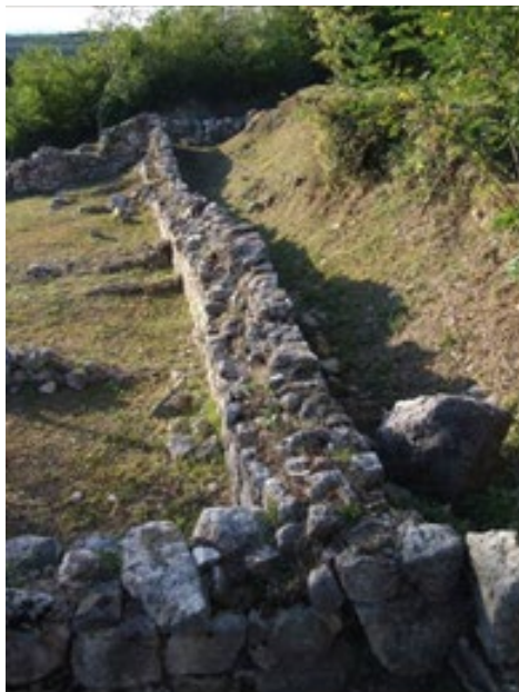
Sl. 257. Pogled sa sjevera na zid SJ 1 prije radova konzervacije
