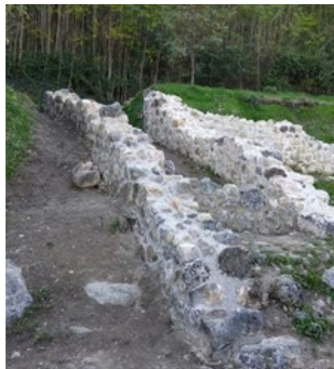
Sl. 262. Pogled s juga na zid SJ 3 nakon radova konzervacije
