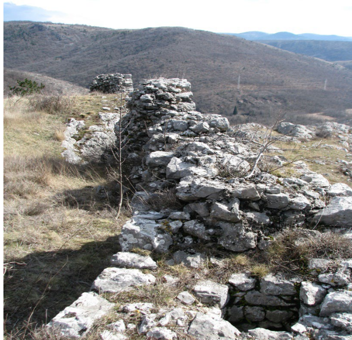
Sl. 346. Ostaci nekadašnjeg obrambenog zida s jugoistočne strane utvrde Zvonigrad
