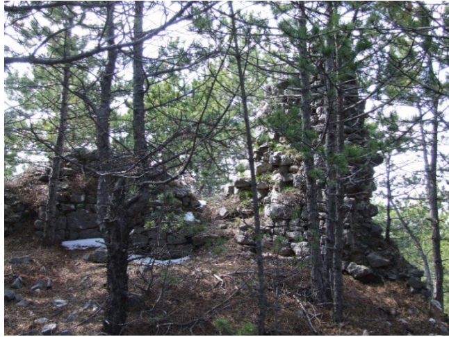
Sl. 334. Ostatak zida kružne kule na jugozapadu i ostatak kružne kule u temeljima na zapadu utvrde
