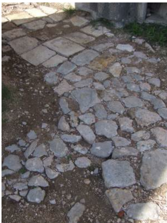
Sl. 228. Današnji izgled dijela rekonstruirane staze unutar vrata koja vode za Srednji grad (kaštel)
