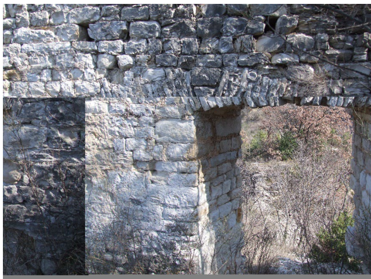
Sl. 63. Pogled na ulaz utvrde Bogočin s njegove vanjske strane
