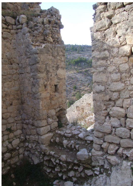
Sl. 47. Ulaz na jugozapadnoj strani utvrde
