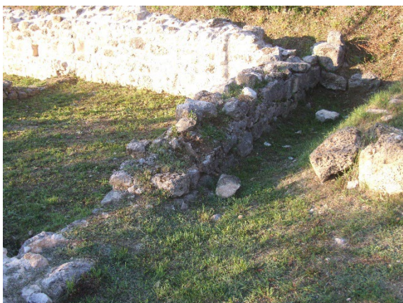
Sl. 265. Pogled s istoka na zid SJ 6 prije radova konzervacije
