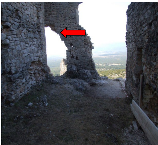
Sl. 77. Pogled na ulaz u Prostoriju 2
