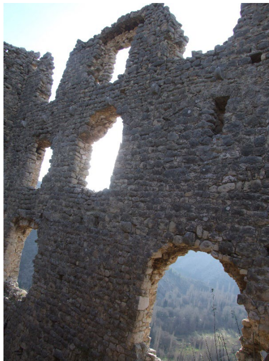
Sl. 39.c Orambeni zid s jugozapadne strane utvrde koi je ujedno i zid jedne od prostorija
