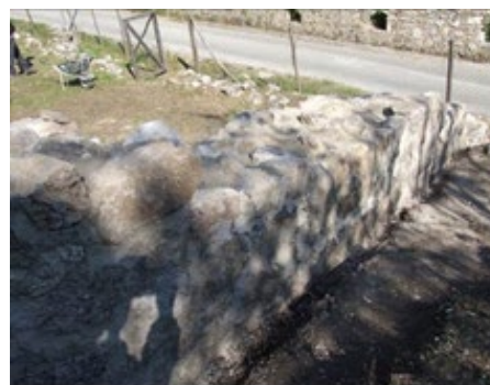
Sl. 260. Pogled sa zapada na zid SJ 2 nakon radova konzervacije
