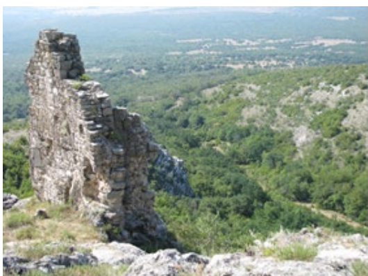
Sl. 132. Pogled sa sjevera na zid SJ13 prije konzervatorskih radova
