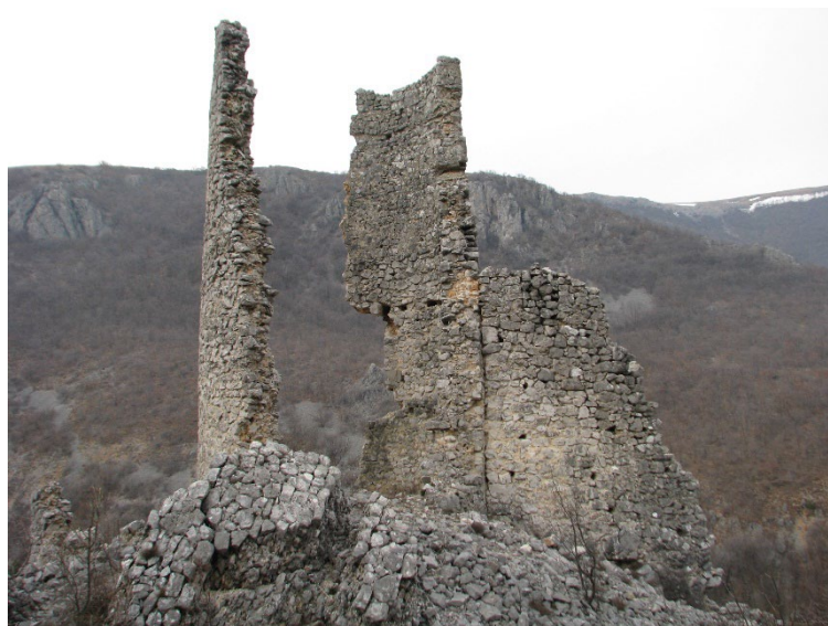
Sl. 374. Pogled na jugoistočni ostatak zidova kružne kule (?) (17. studenoga 2015.)
