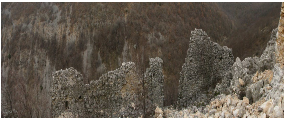
Sl. 381. Pogled na obrambeni zid na sjeverozapadu utvrde (17. studenoga 2015)
