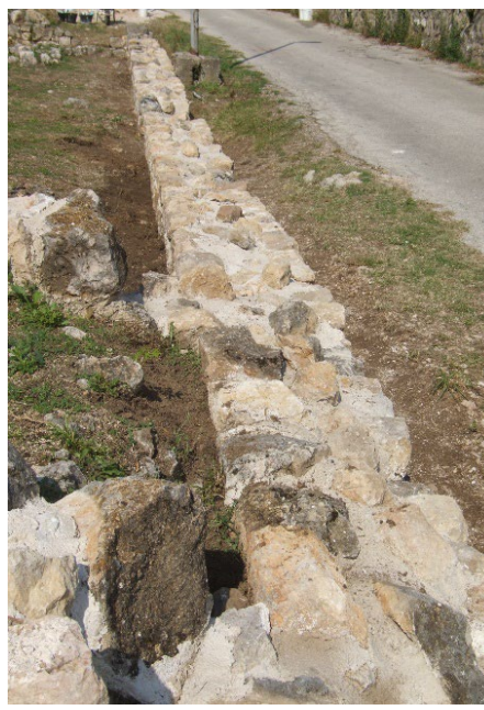
Sl. 264. Pogled s juga na zid SJ 5 nakon radova konzervacije
