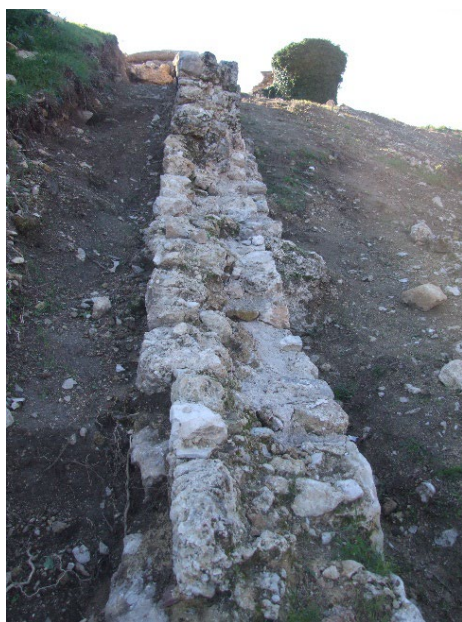
Sl. 183. Pogled sa sjevera na obrambeni zid
