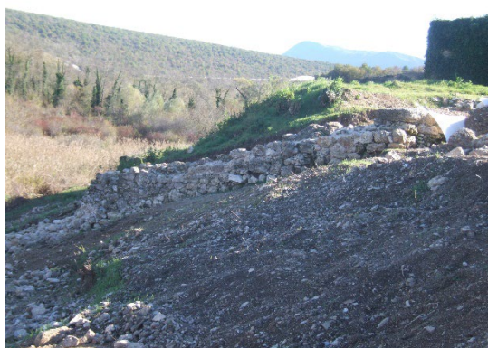
Sl. 182. Pogled na obrambeni zid sa sjeveroistočnoj strani Kapitula
