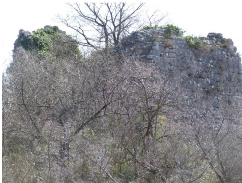
Sl. 4. Pogled na sjeverozapadni zid utvrde
