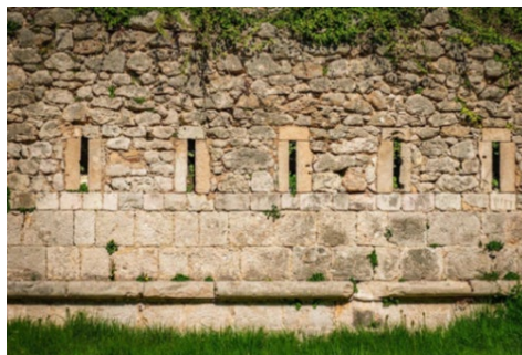
Sl. 469. Primjer puškarnica na Kaštel Kninu (foto: Neven Rogić, 2020.)
