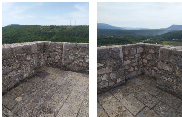
Sl. 449. a - b Dogradnje na Bastionu Belveder
