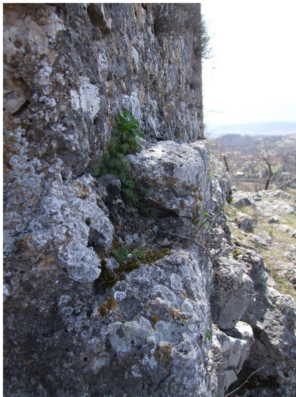
Sl. 7. Pogled na jugoistočni zid i ojačanje temeljne stope utvrde
