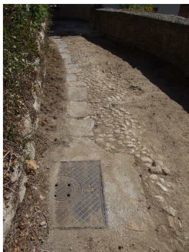
Sl. 269. Pogled na popločenje (kaldrmu) nakon skidanja sloja asfalta i zemlje
