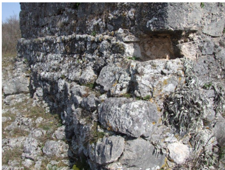
Sl. 5. Pogled na sjeveroistočni zid i ojačanje temeljne stope utvrde
