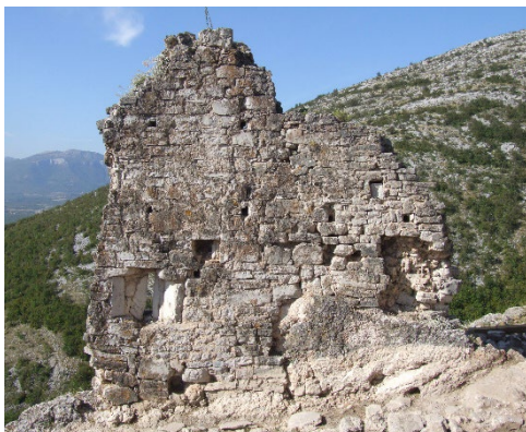
Sl. 128. Pogled s istoka na zid SJ 12 prije konzervatorskih radova
