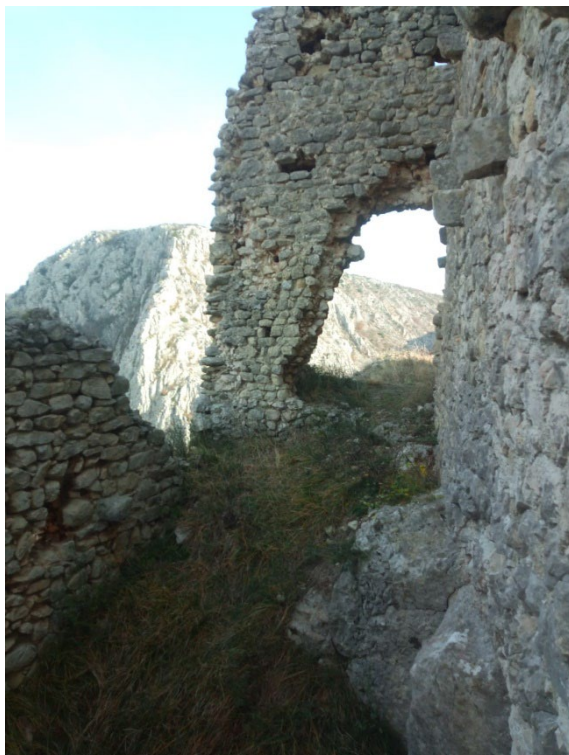
Sl. 52. Pogled na sjeveroistočnu i dijelom istočnu stranu utvrde
