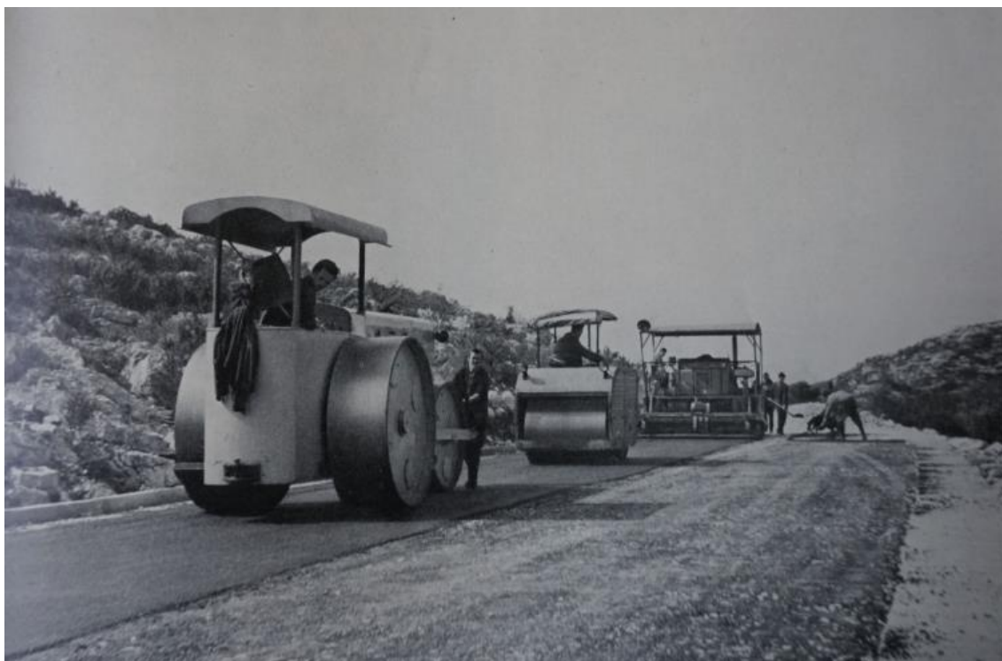
Prilog 8. Fotografija, izgradnja Jadranske magistrale. Izvor: Geotech d.o.o., https://www.geotech.hr/jadranska-magistrala-cesta-koja-je-promijenila-hrvatsku/ , pregledano 28.3.2023.
