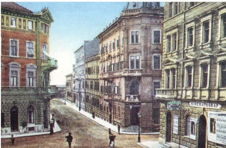
Sl. 3.18. Pogled na historicističke stambeno-poslovne zgrade središta Sušaka, današnja Ulica Milana Smokvine Tvrdog, Rijeka
