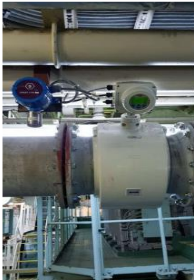
Slika 9. Mjerac protoka[5]
