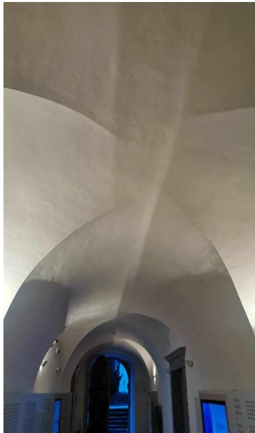
Slika 34. Križni svod u prizemlju (foto: L. Bajt)
