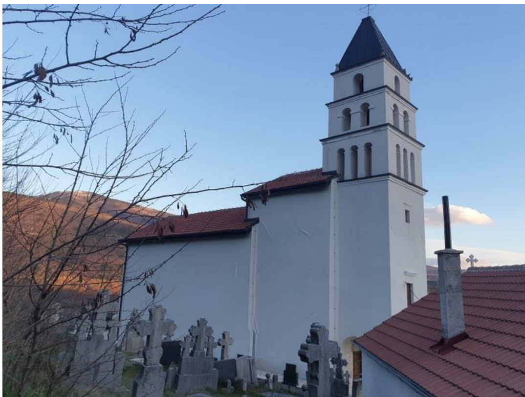
Prilog 10. Pogled na crkvu sa sjeverozapada, foto: Ivan Josipović
