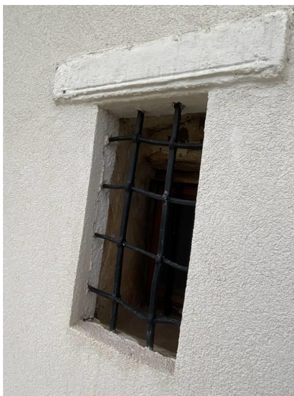
Prilog 12. Prozor na južnom zidu crkve; vidljiva debljina zida, foto: Dolores Perković
