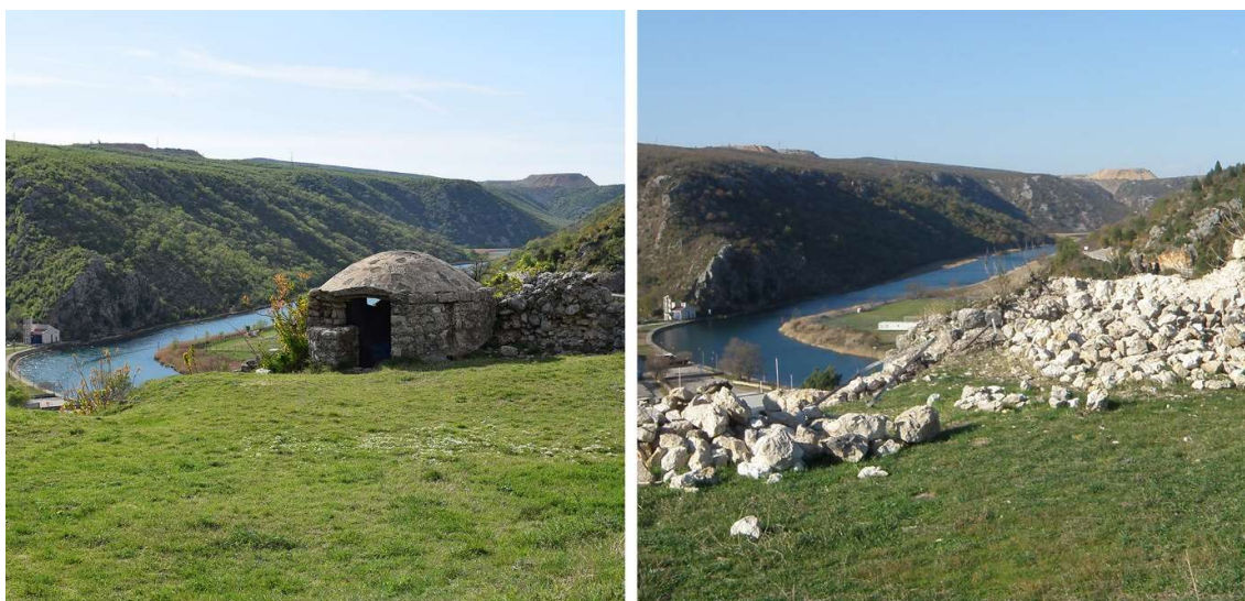
Slike 125-126. Betonski bunker na Fortici u Obrovcu prije i poslije rušenja (snimio Š. Vrkić)
