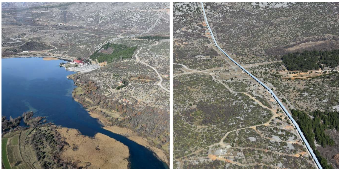
Slike 118-119. Reverzibilna hidroelektrana Velebit u Muškovcima (snimila V. Glavaš)
