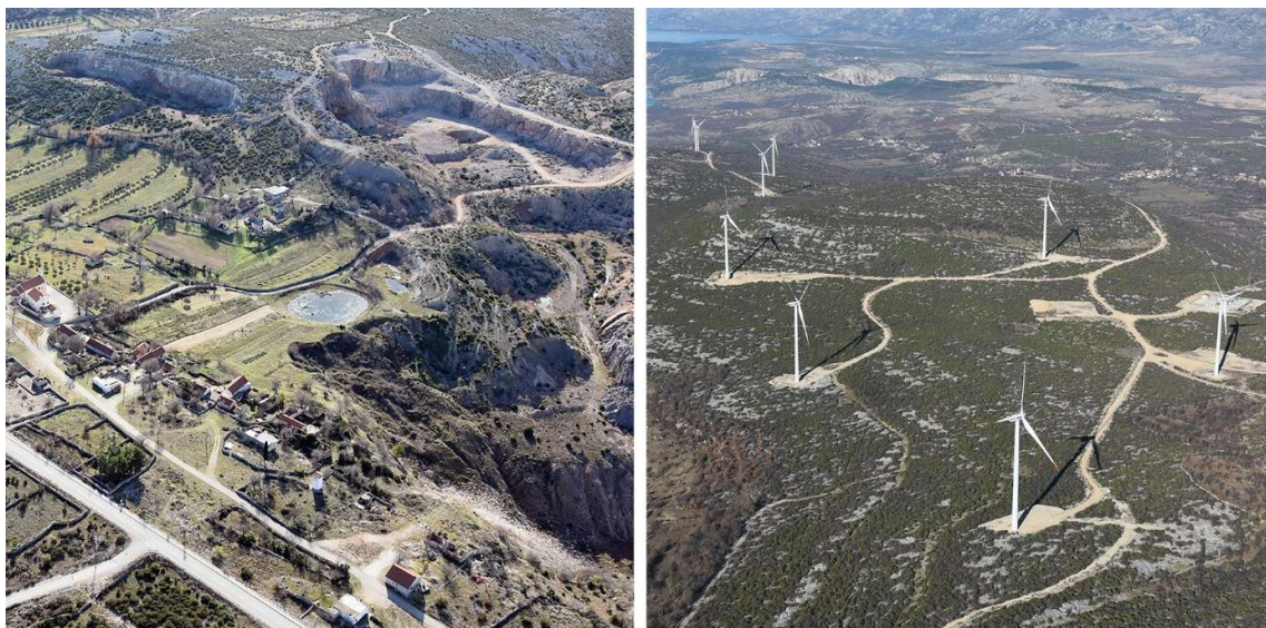
Slike 116-117. Rudokopima raskopano središte Jasenica i vjetroelektrana na brdu Orljak u Kruševu (snimila N. Kulenović)
